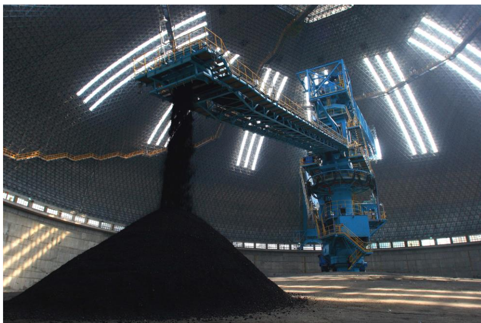
■ 台電公司-興達發電廠室內煤倉進煤作業
