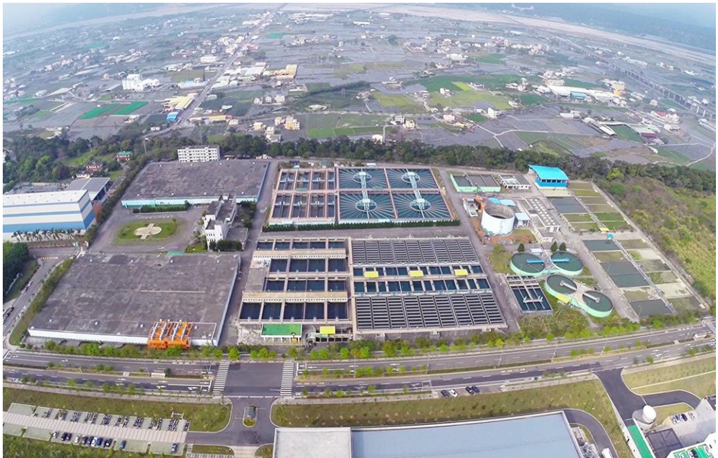
■ 台水公司-鯉魚潭淨水場
