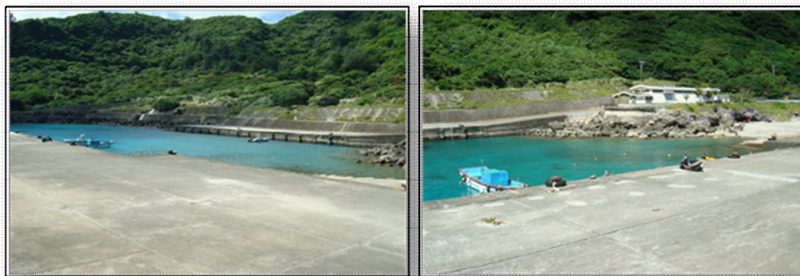
圖 2.5-1 蘭嶼貯存場龍門碼頭現況
