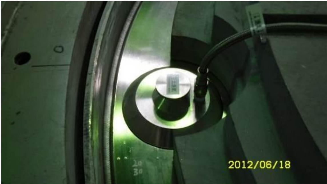
圖 3.1.5 氫氣偵檢與氫氣沖流系統於排水孔側管路特寫
