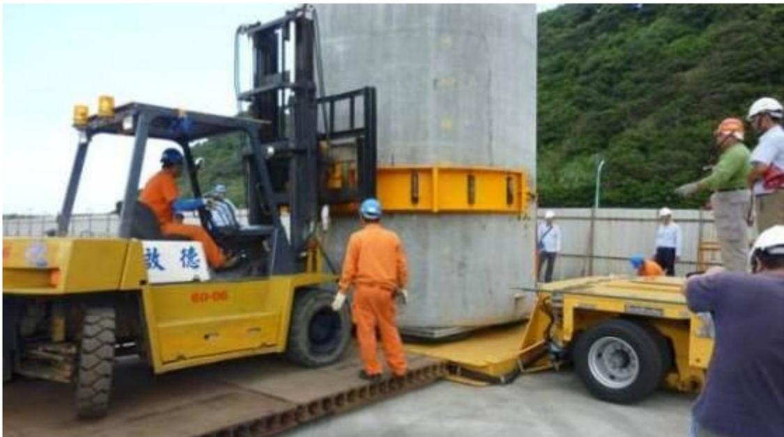
圖 3.2.24 VCC 移至多軸油壓板車上
