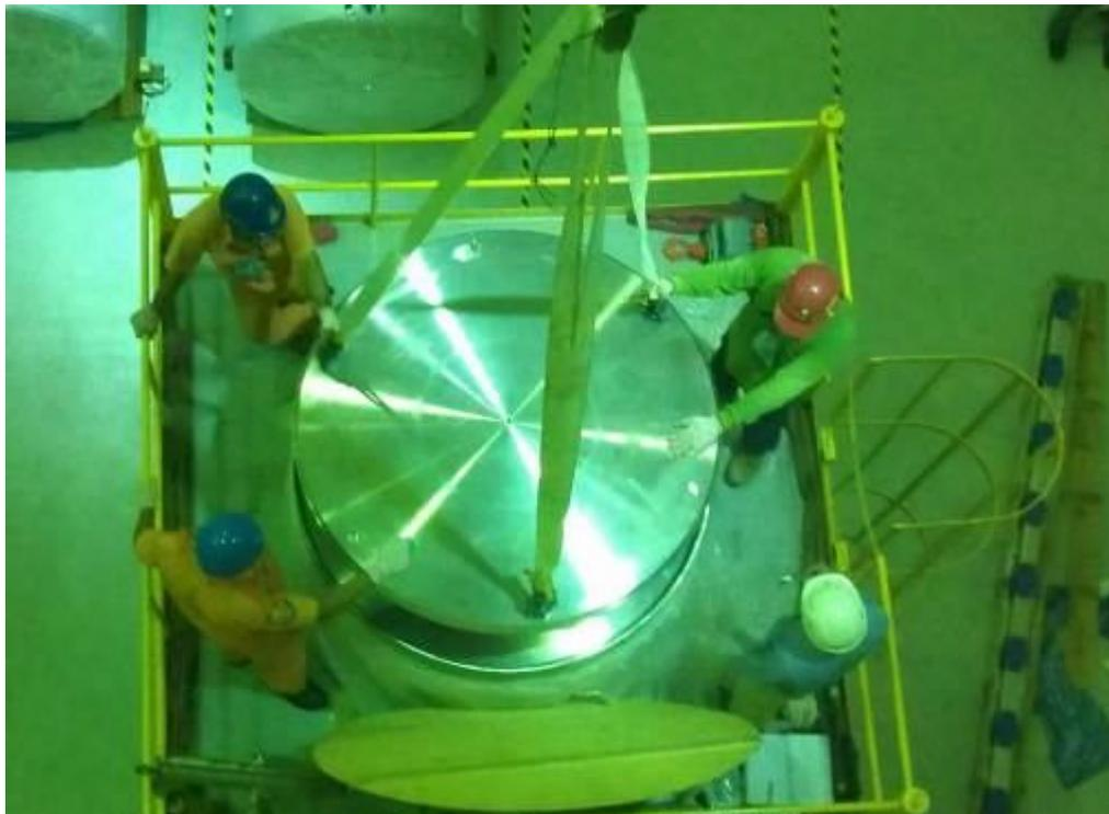
圖 3.2.8 密封鋼筒與結構上蓋組合測試
