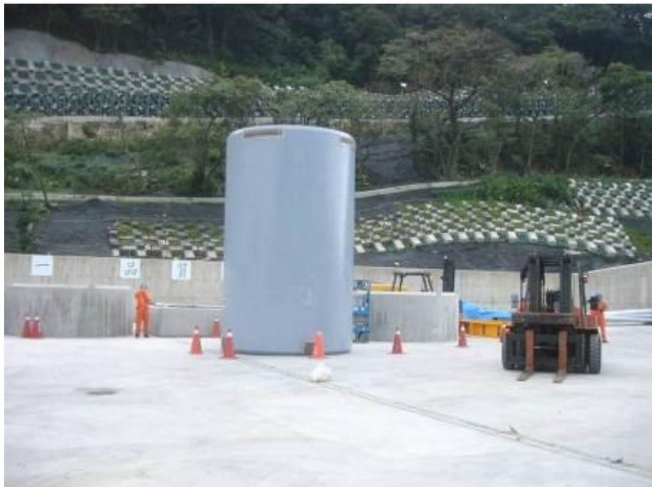
圖 3.2.64 混凝土護箱貯放於指定位置
