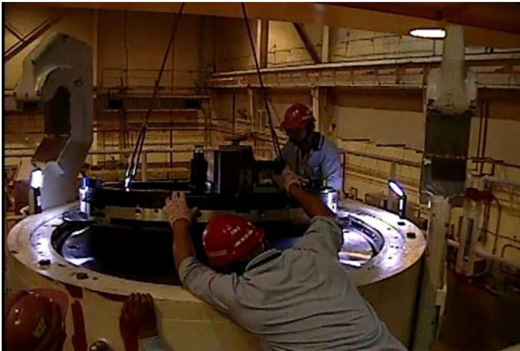
圖 3.2.50 銲道切除裝置安裝於結構上蓋上
