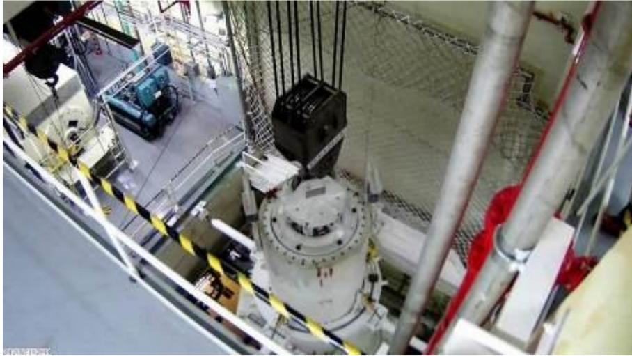
圖 3.2.31 以可遙控脫鈎吊具將 TSC 放入 VCC 內
