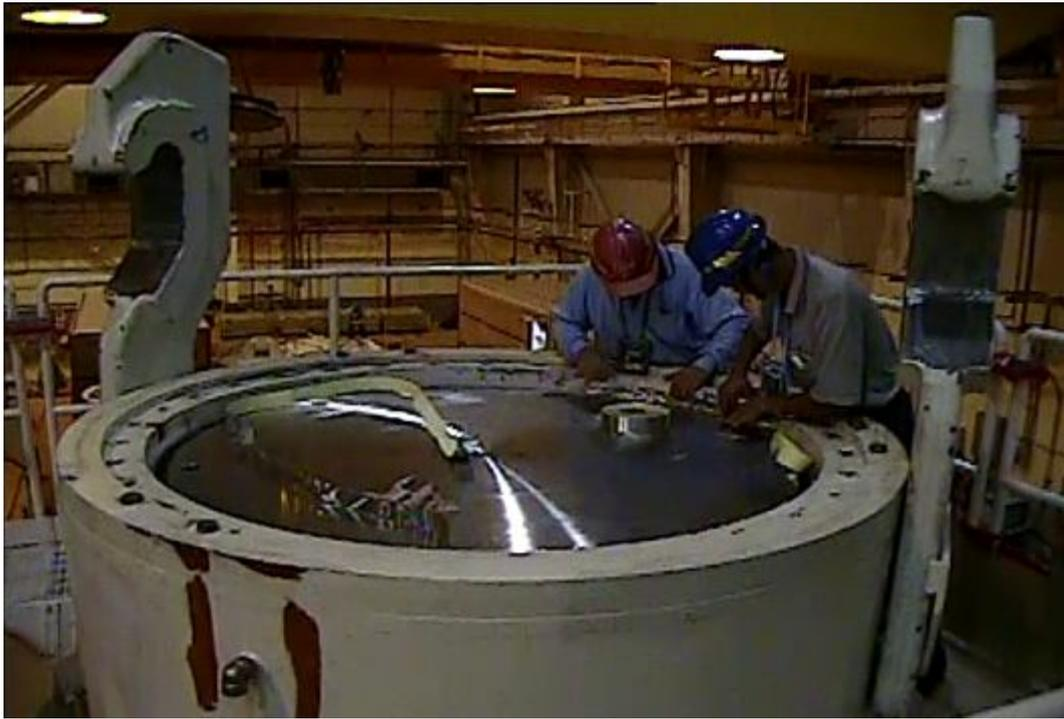
圖 3.2.49 利用金屬膠帶將間隙填補
