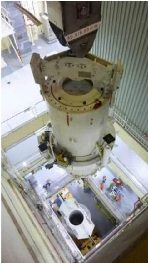
圖 3.2.28 傳送護箱穿越天井往 VCC 吊運
