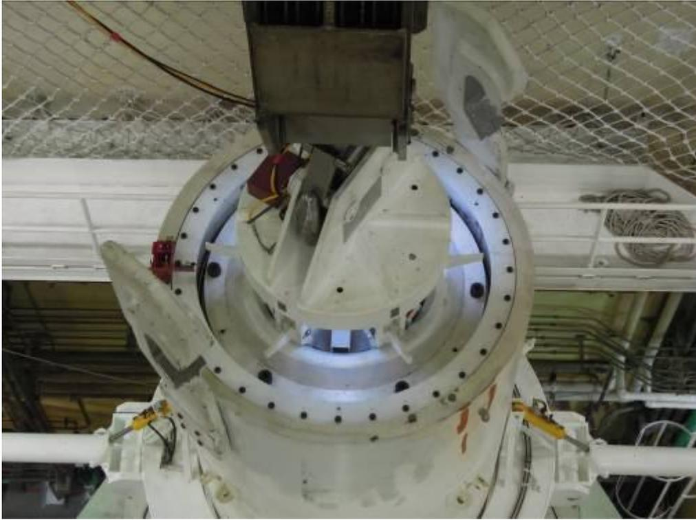
圖 3.2.47 將密封鋼筒吊入傳送護箱內
