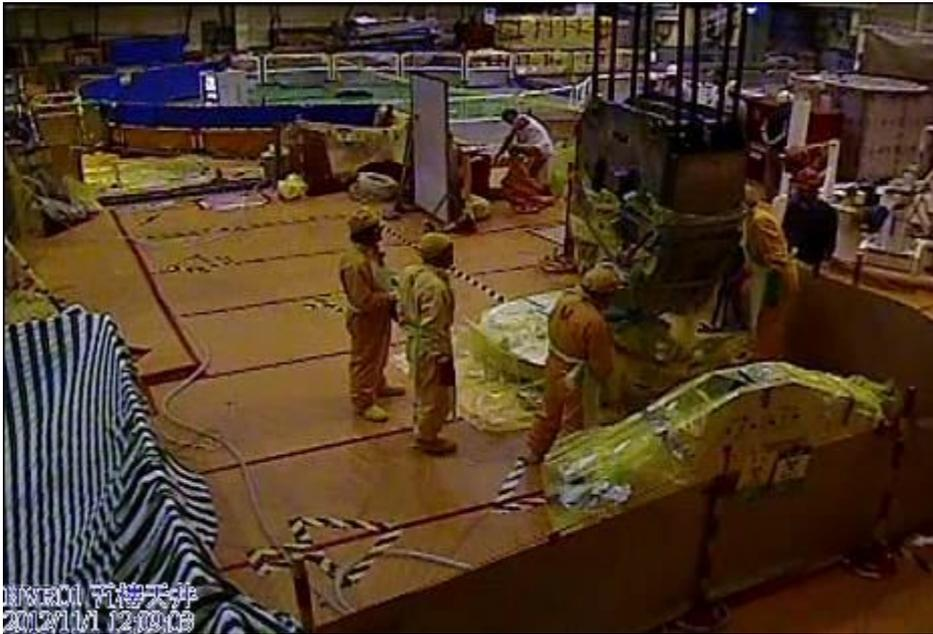
圖 3.3.7 出水後的吊軌與吊勾套袋後收存
