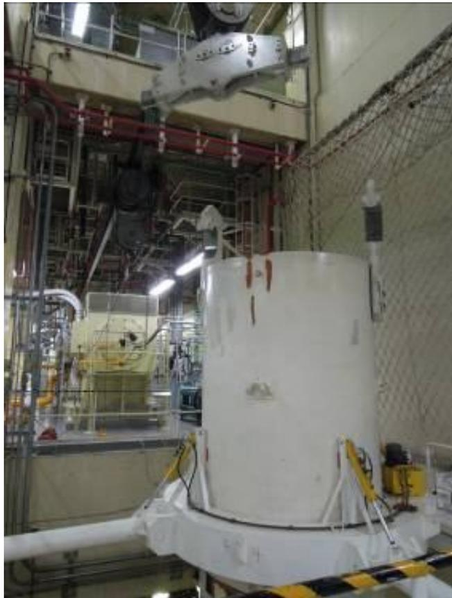
圖 3.2.48 準備以吊軛將傳送護箱吊至 5F
