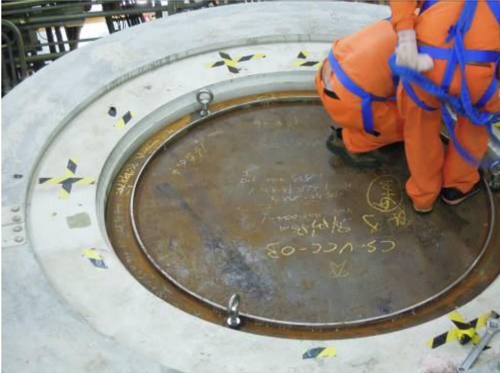
圖 3.2.41 準備將 VCC 之屏蔽塞吊離
