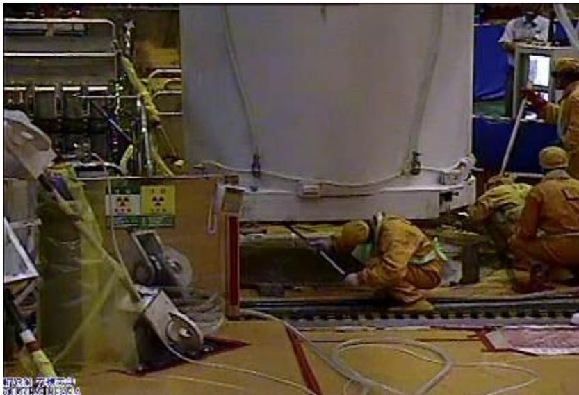
圖 3.3.18 傳送護箱底部擦拭除污
