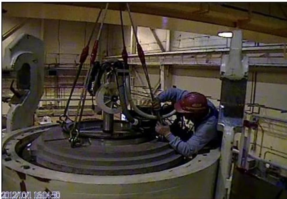
圖 3.2.22 結構上蓋安裝自動銲接機
