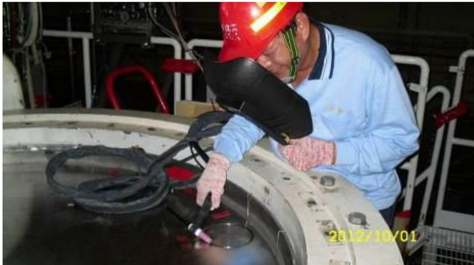
圖 3.2.20 模擬排水排氣孔口蓋銲接作業
