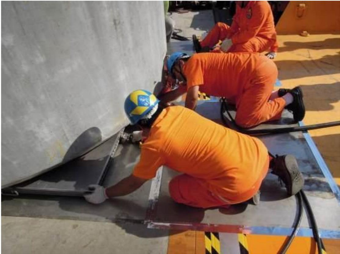
圖 3.2.23 VCC 底部安置懸浮氣墊組
