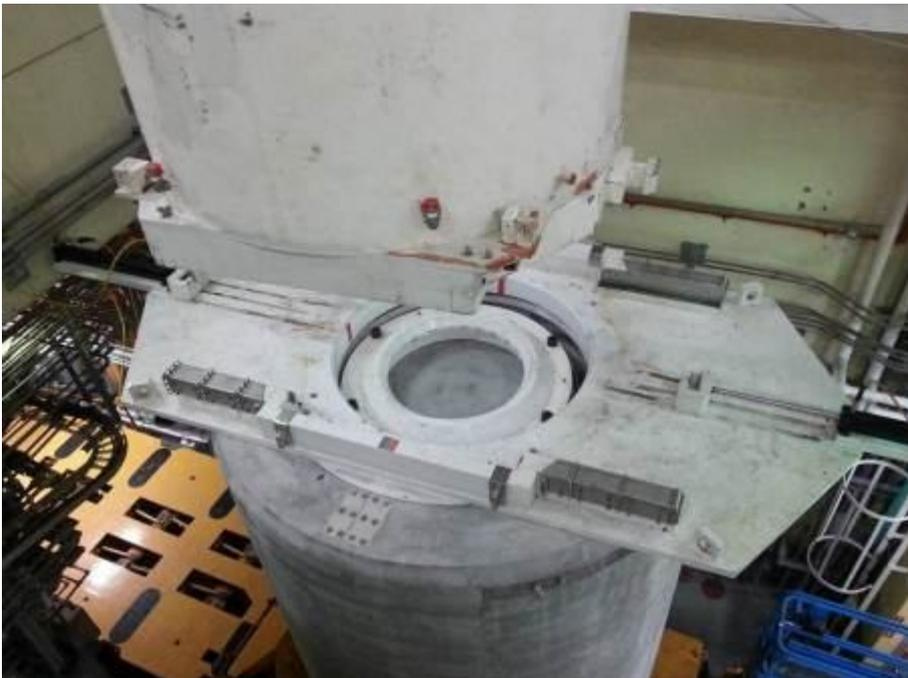
圖 3.2.32 密封鋼筒順利傳送進 VCC 內並將傳送護箱吊離
