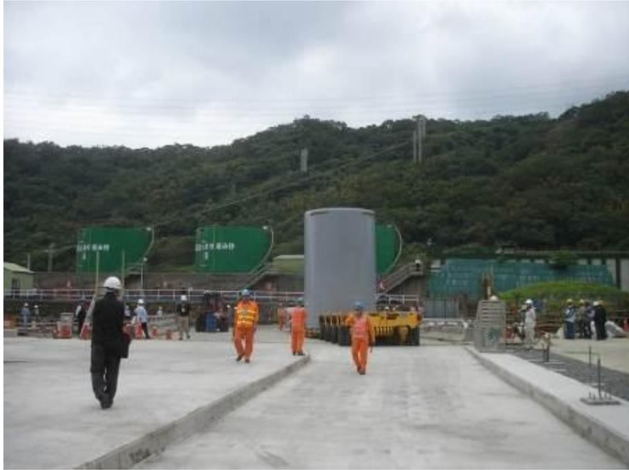
圖 3.2.61 混凝土護箱通過乾華橋
