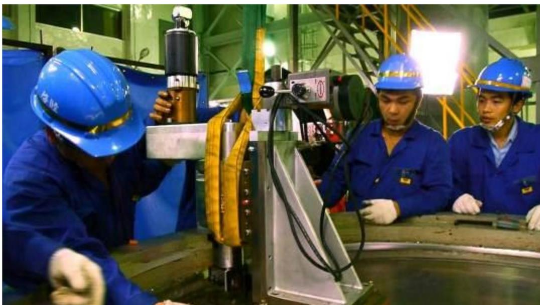
圖 3.1.17 安裝封口蓋銲道切削設備
