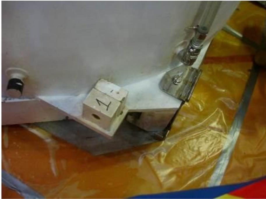
圖 3.3.1 傳送護箱底部防污板安裝完成貌
