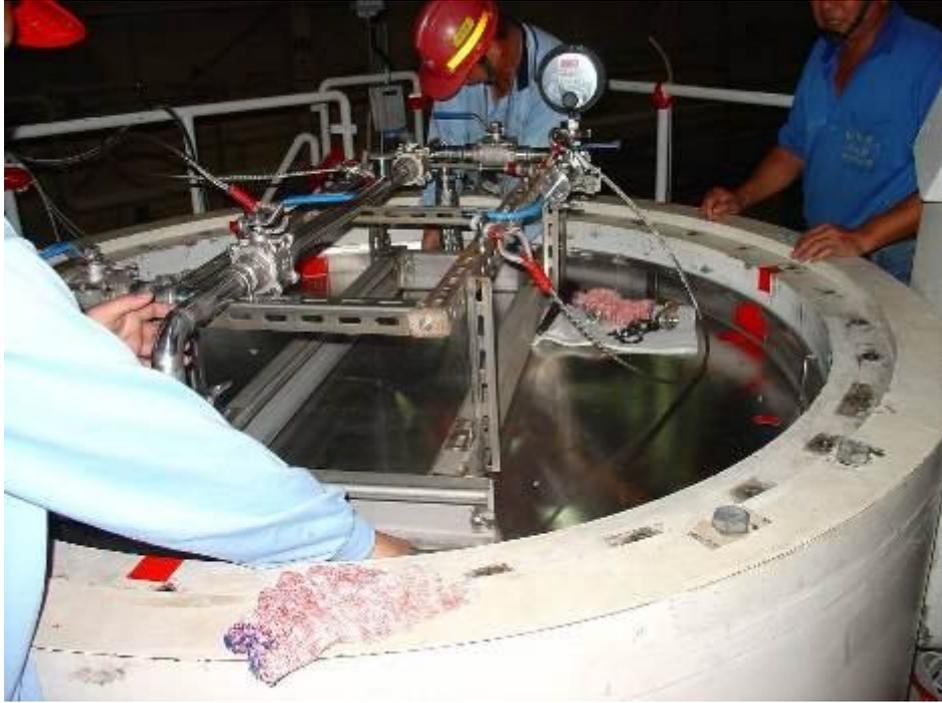
圖 3.2.19 安裝真空乾燥系統儀表架
