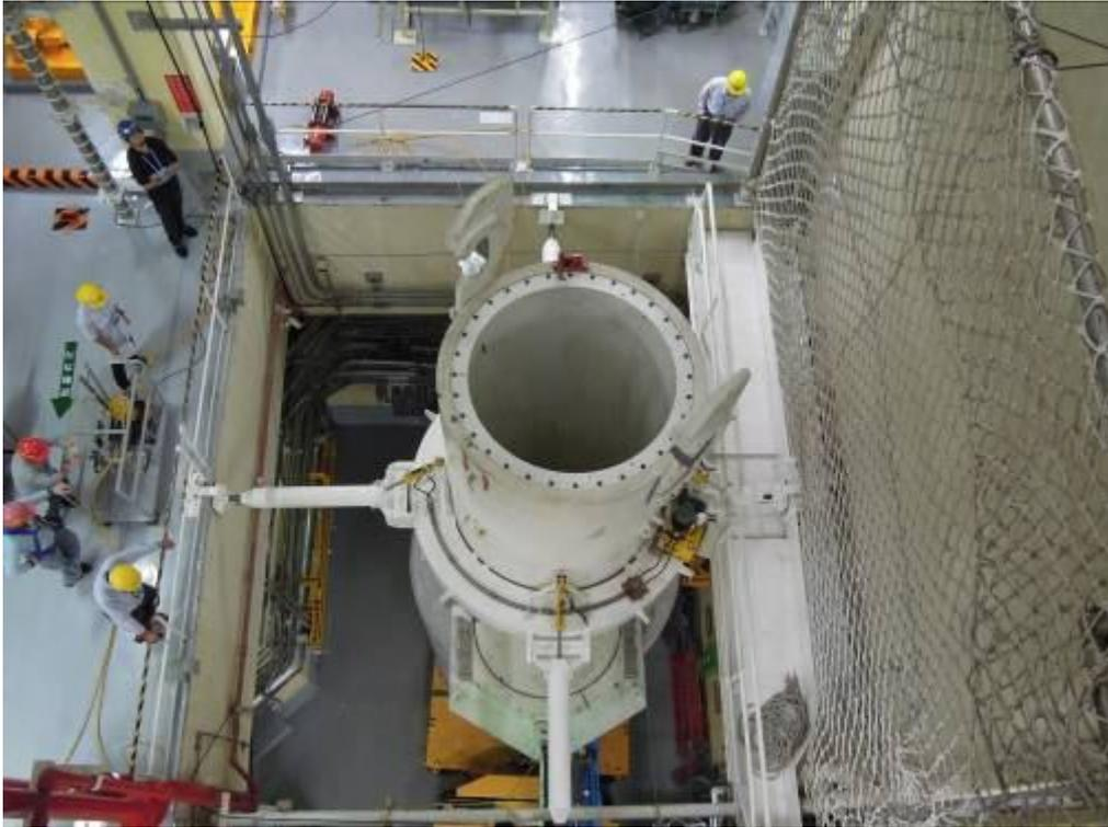
圖 3.2.45 傳送護箱座妥後放下 2F 防震裝置
