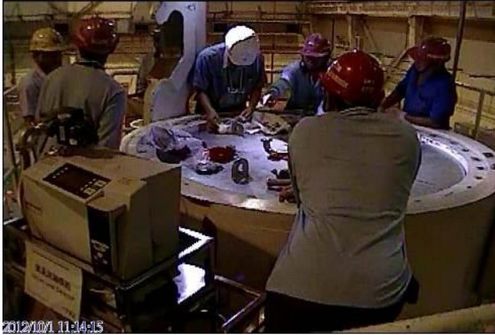
圖 3.2.21 安裝氮氣測漏儀
