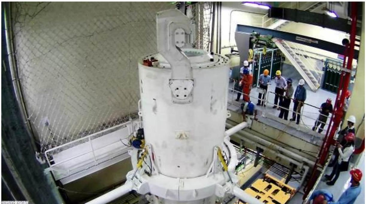
圖 3.2.30 傳送護箱外側二樓防震裝置展開並固定(2 of 2)
