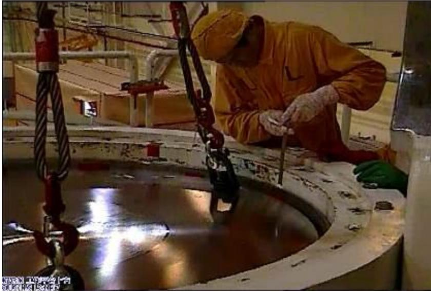
圖 3.3.19 對密封鋼筒外壁進行拭跡偵檢作業
