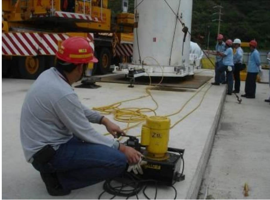
圖 3.2.3 以油壓系統開關屏蔽門
