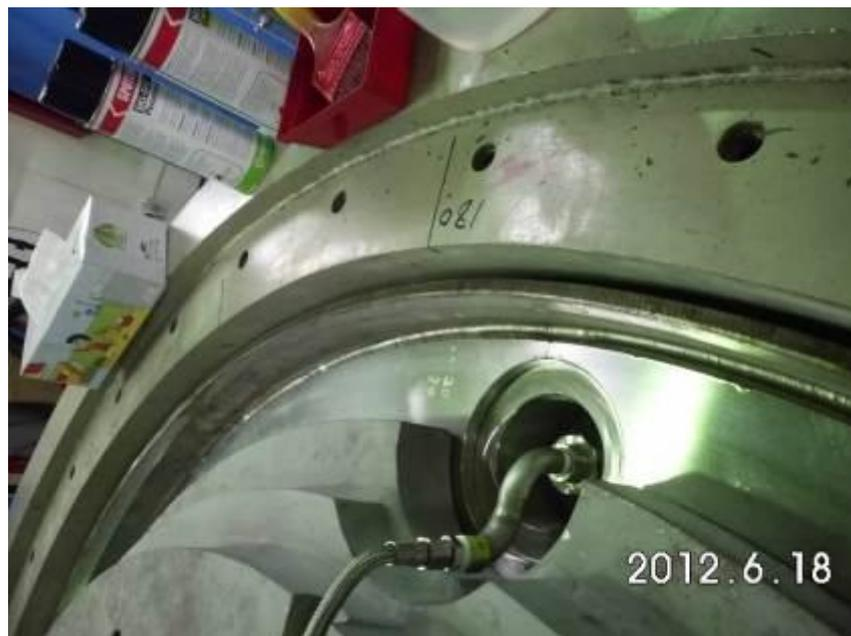
圖 3.1.6 氫氣偵檢與氫氣沖流系統於排氣孔側管路特寫
