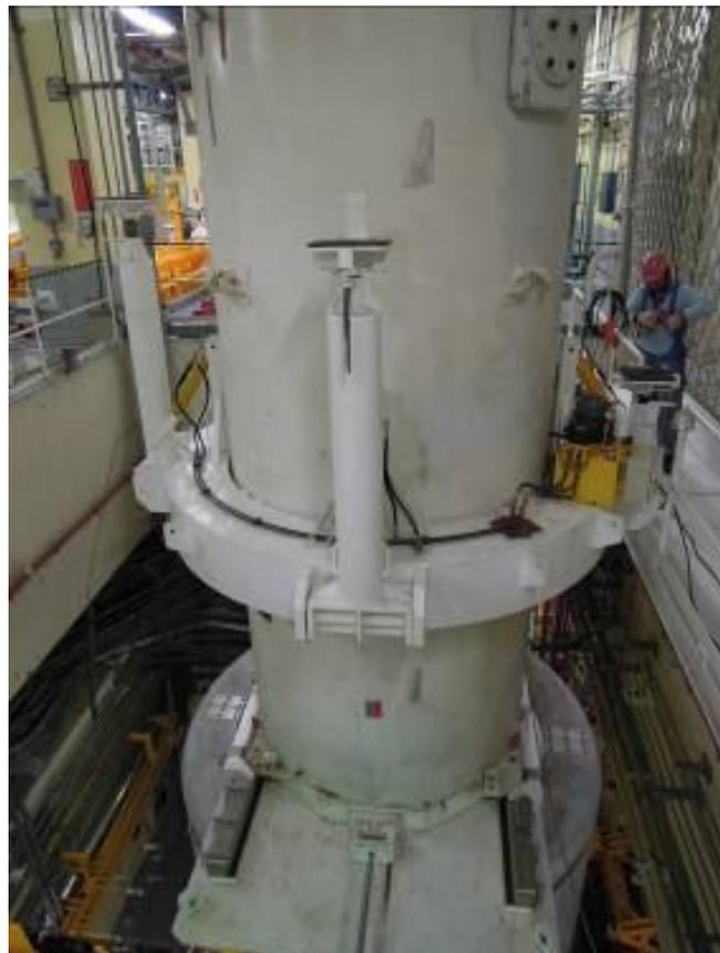
圖 3.2.44 以吊軛將傳送護箱吊置於 VCC 上
