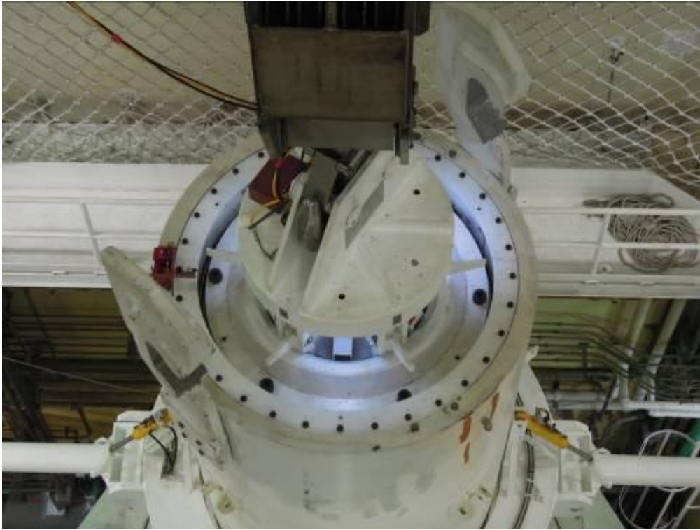
圖 18 將密封鋼筒吊入傳送護箱內
