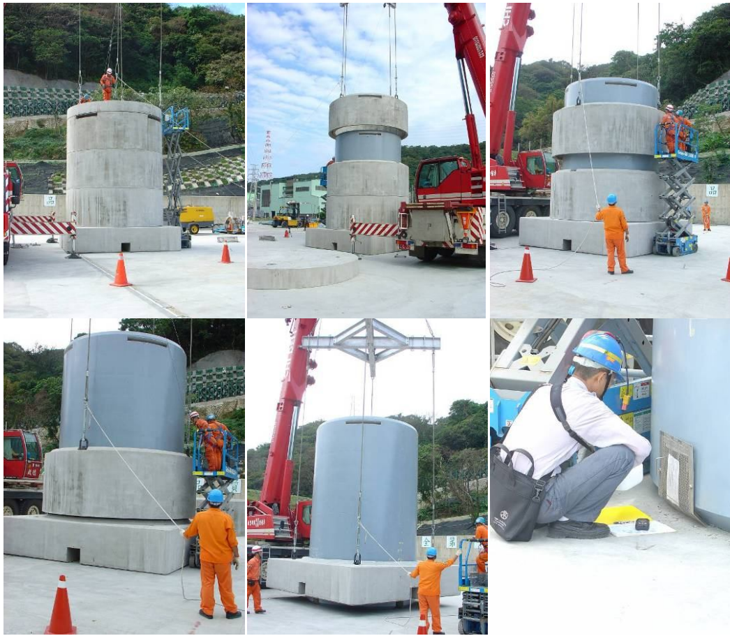
圖 3 吊離外加屏蔽進行輻射偵檢
