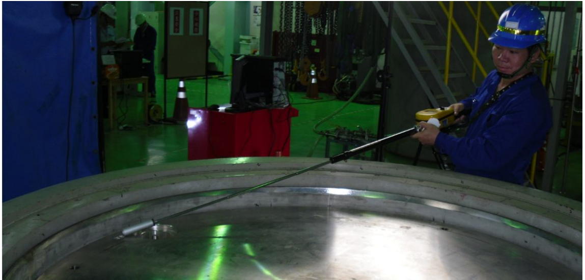
圖 22 輻防人員進行銲接區域輻射偵測
