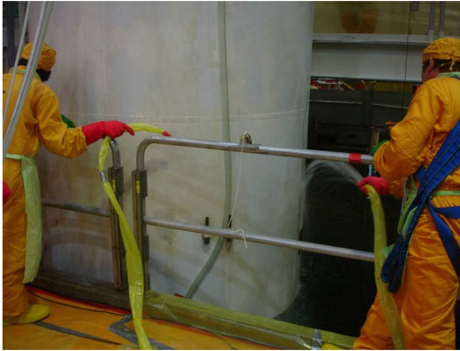
圖 44 下水時傳送護箱表面持續淋濕
