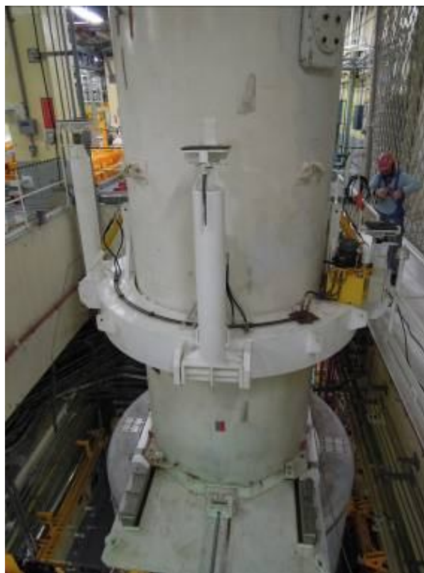
圖 15 以吊軛將傳送護箱吊置於混凝土護箱上
