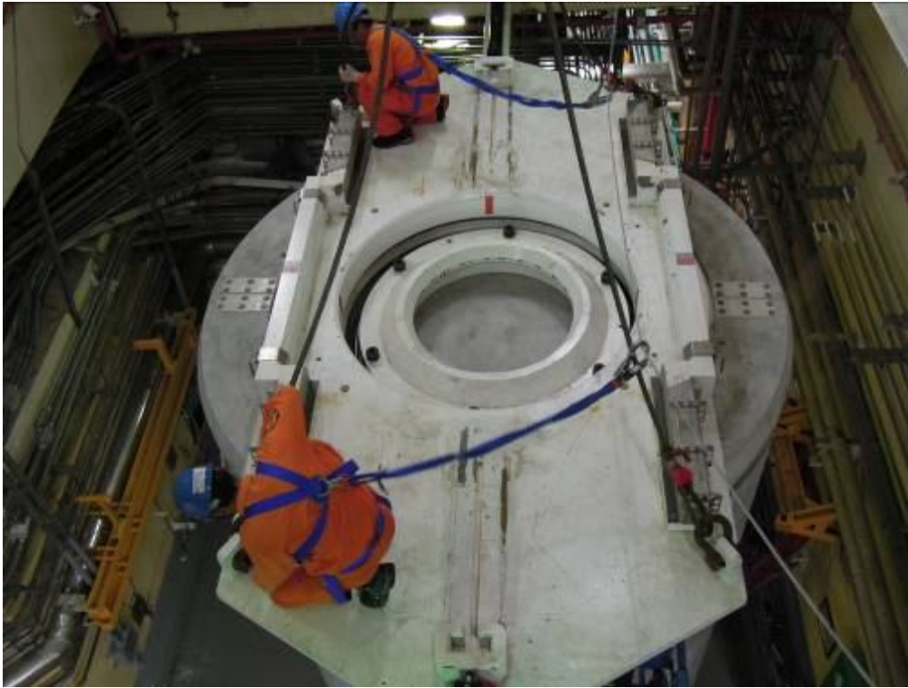
圖 14 於混凝土護箱上安裝銜接器
