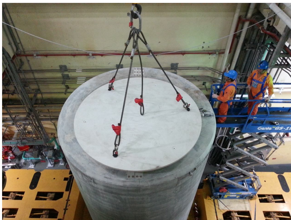
圖 11 將混凝土護箱之頂蓋吊離
