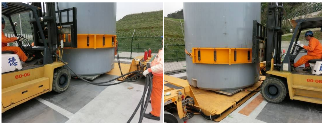
圖 5 混凝土護箱由貯存場貯存位置移至多軸油壓板車上
