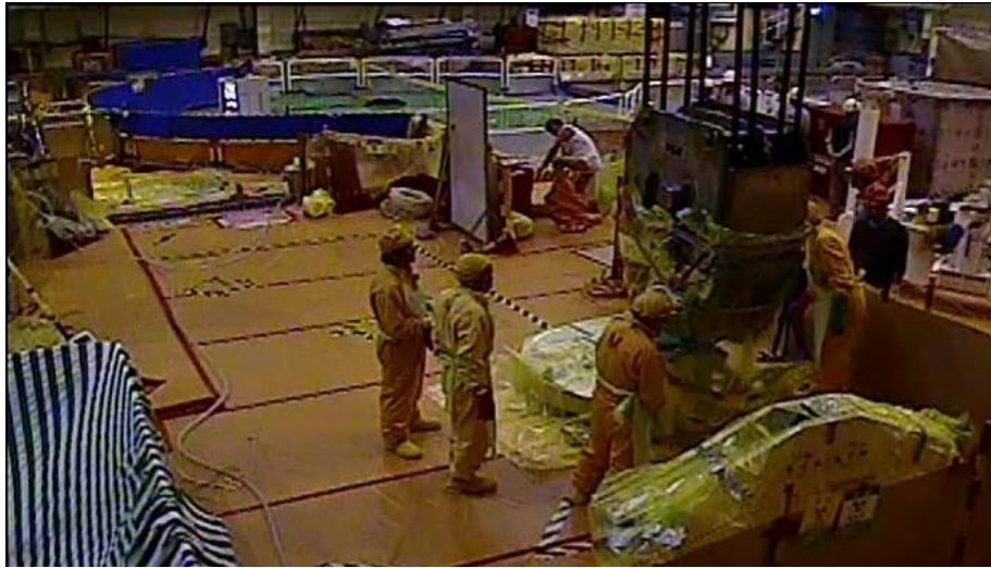
圖 50 出水後的吊軌與吊勾套袋後收存
