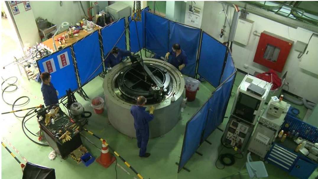
圖 23 結構上蓋銲道切割
