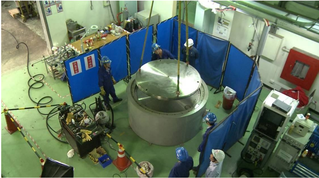
圖 26 結構上蓋成功吊離
