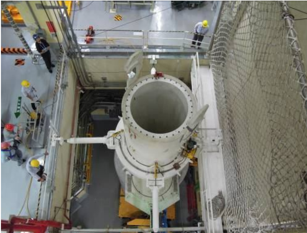
圖 16 傳送護箱座妥後放下 2 樓防震裝置
