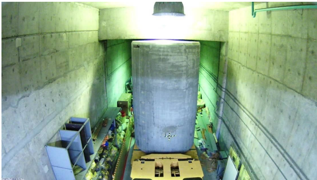
圖 9 混凝土護箱移至反應器廠房雙重氣密門間
