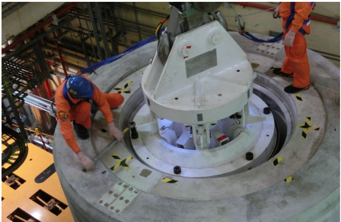
圖 13 安裝可遙控脫鉤吊具之吊環於鋼筒上
