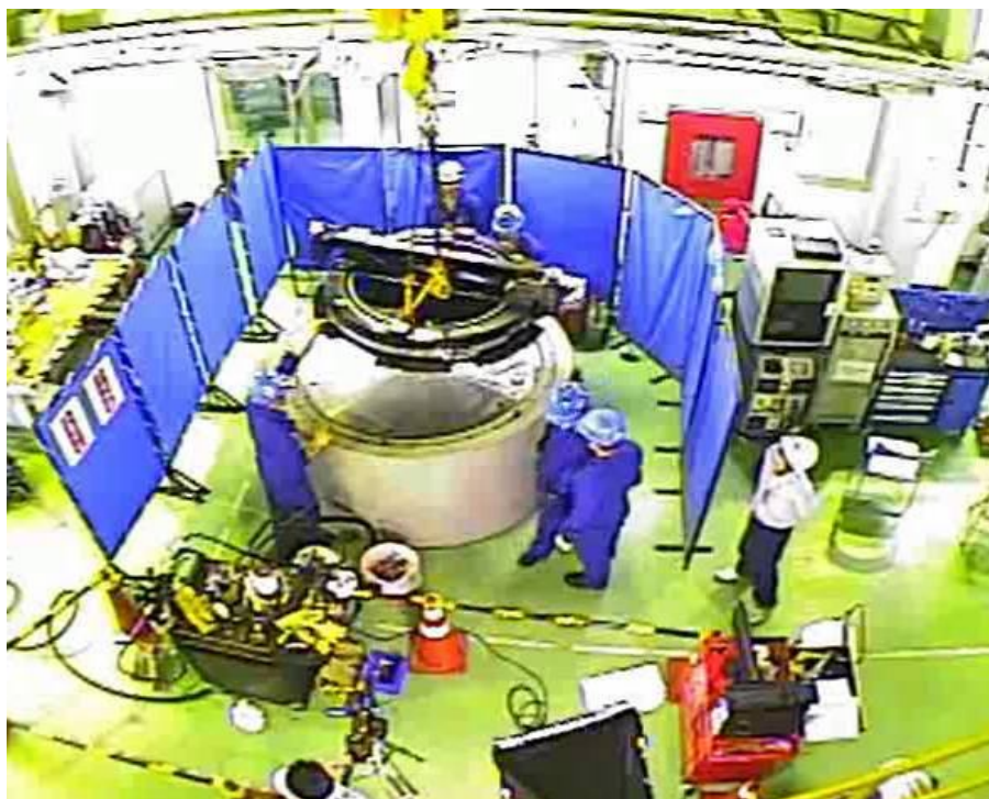
圖 25 吊離鉚道移除設備
