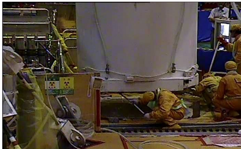
圖 49 傳送護箱底部擦拭除污
