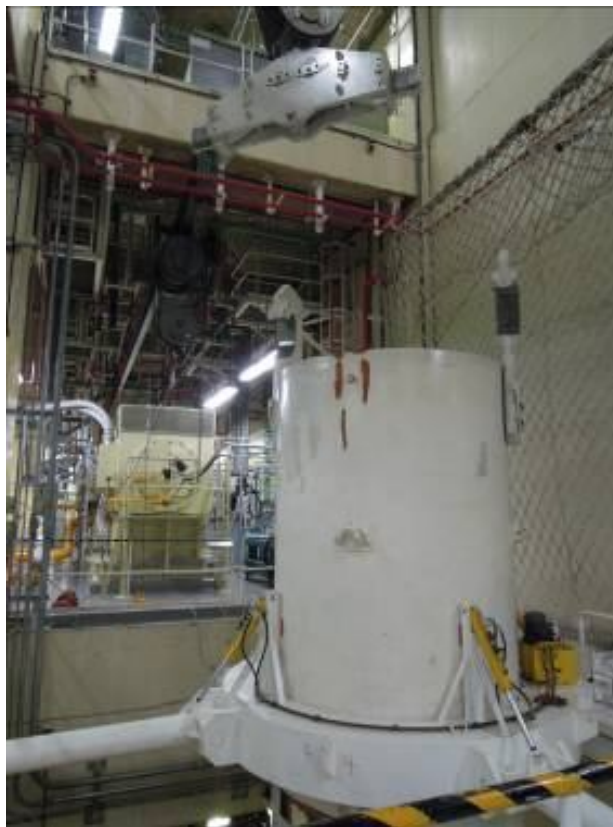
圖 19 準備以吊軌將傳送護箱吊至 5 樓
