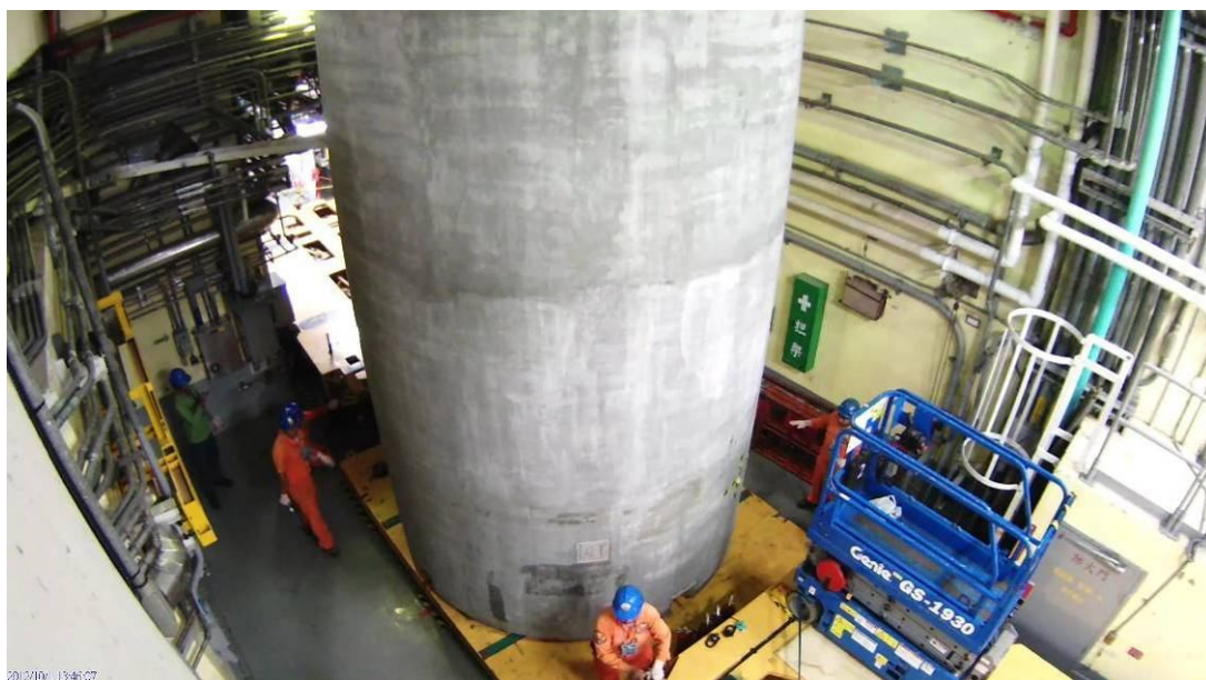
圖 10 混凝土護箱移入反應器廠房 1 樓定位
