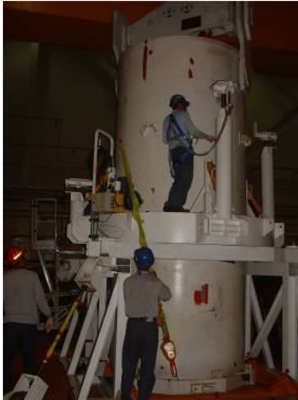
圖 20 傳送護箱與密封鋼筒吊運至 5 樓防震架內
