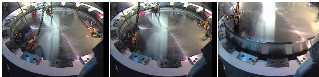
圖 46 於燃料池中將密封鋼筒屏蔽上蓋吊離
