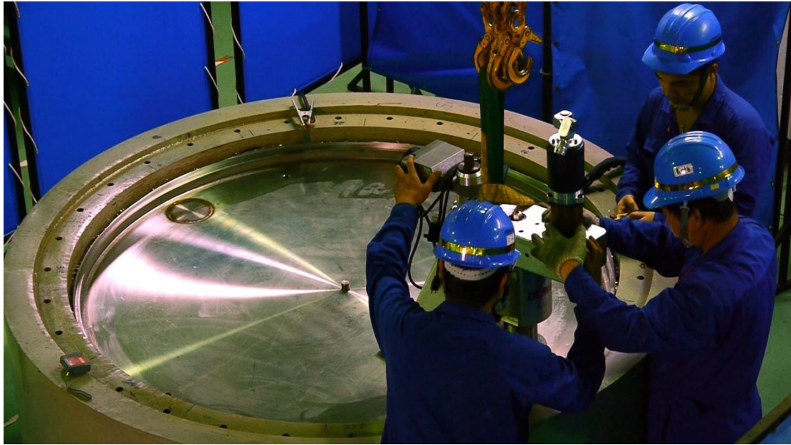
圖 28 安裝封口蓋鐸道切削設備
