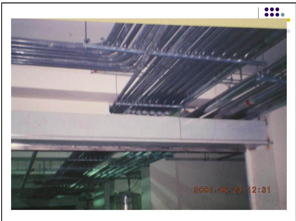
穿過防災區劃(樓板、牆壁、天花板、隔間牆等)之PVC、ABS及含保溫材質管路，應加裝防火填塞物或防火帶隔絕之
