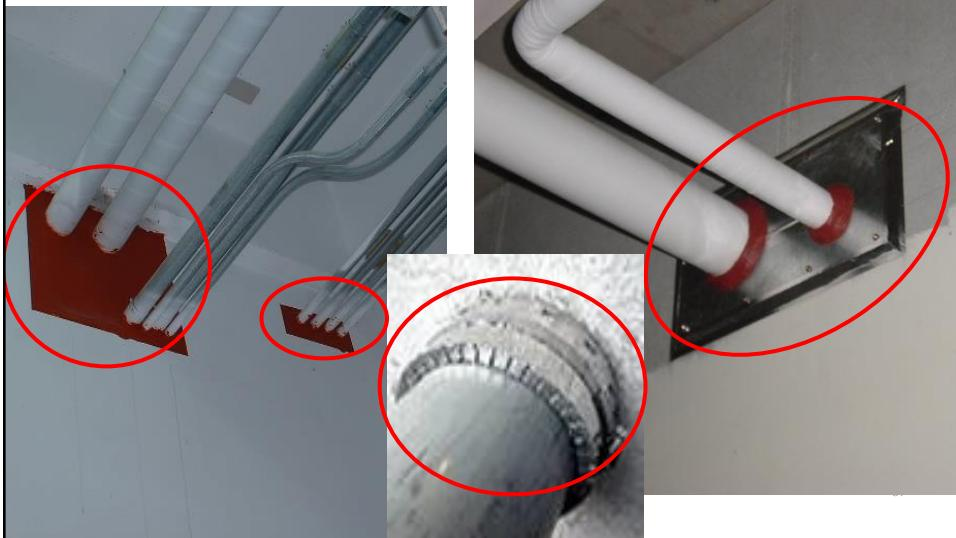
穿過防災區劃(樓板、牆壁、天花板、隔間牆等)之電纜架及匯流排系統，應加裝防火塞物或防火帶隔絕之
