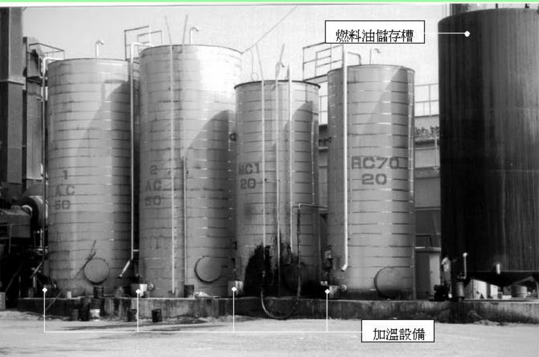
照片 3.7 地瀝青儲存槽。
