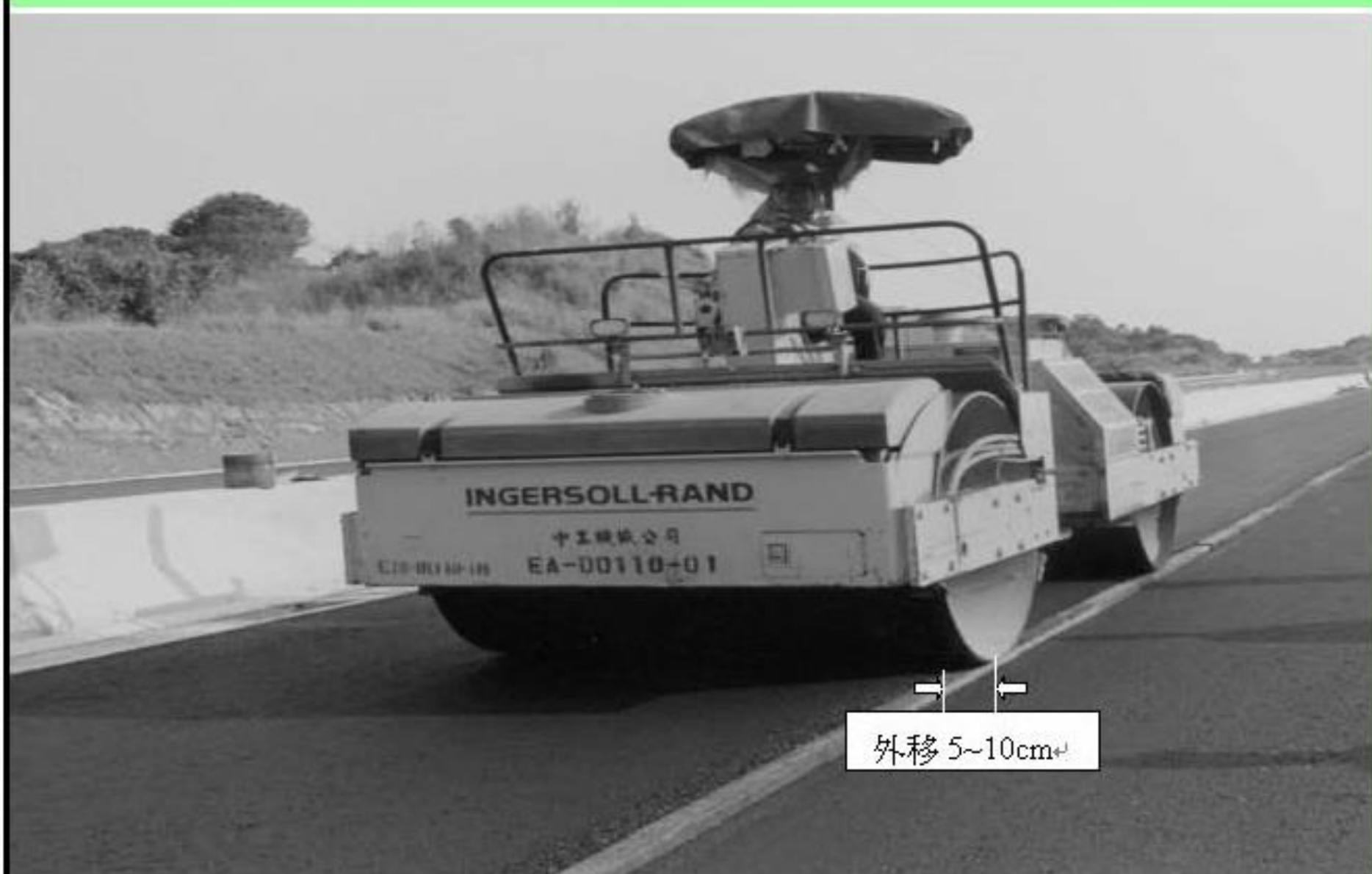
照片 8.4 使用邊模之邊緣滾壓施工
