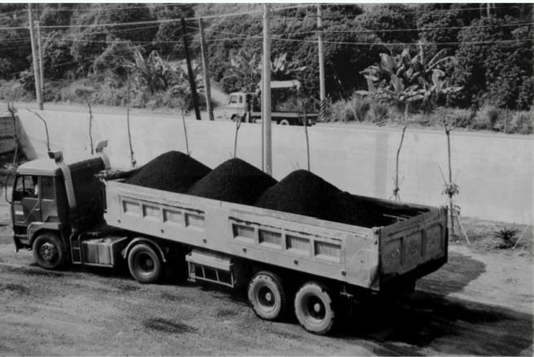
照片 5.3 拌合料裝載完成
