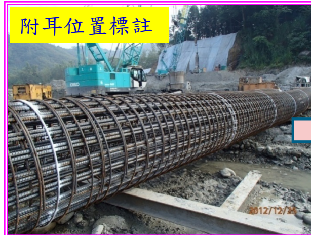
鋼筋籠現場搭接及吊放
