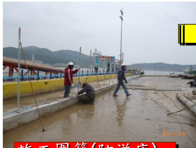
施工圍籬(防溢座)
