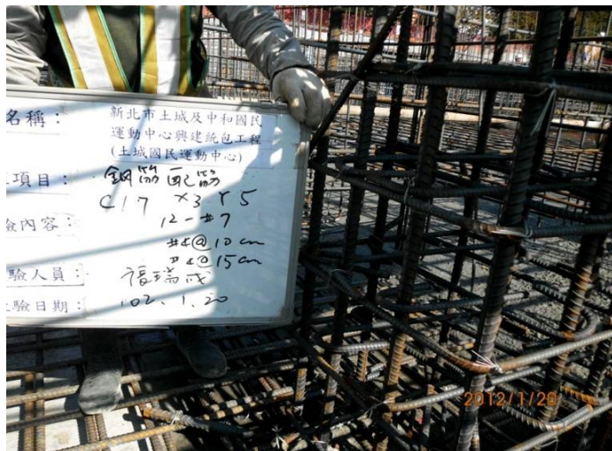
地樑柱筋鋼筋自主查驗
