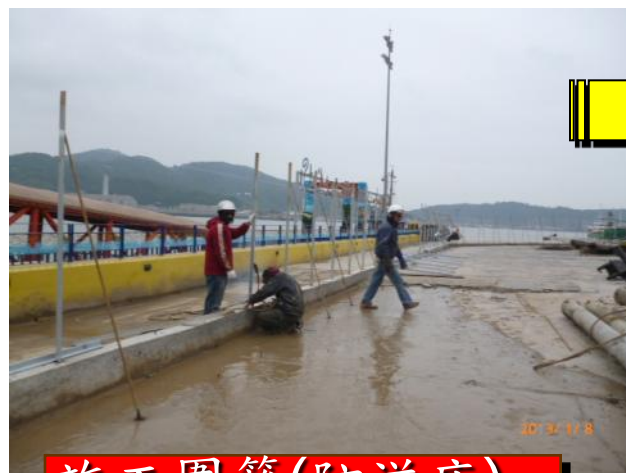
施工圍籬(防溢座)
