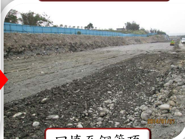
回填至鋼管頂
