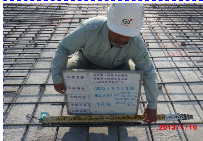
TS版下層筋鋼筋自主查驗
