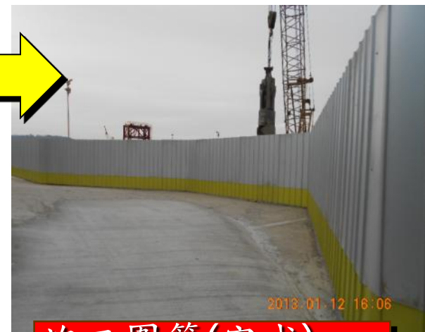
施工圍籬(完成)
