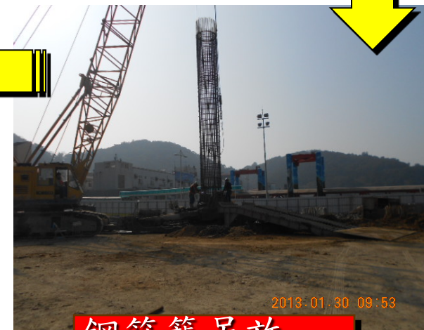
鋼筋籠吊放
