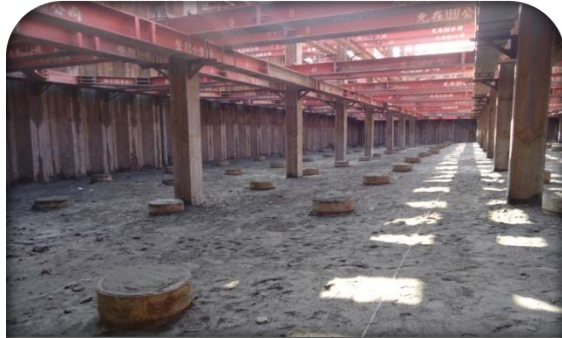
8. 開挖後基樁完成面
