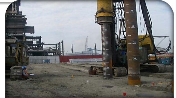
3. 鋼管樁打設
