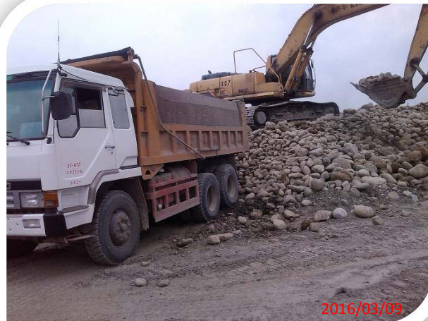
拋石層填築施作照片
