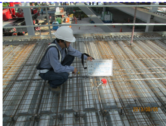
二樓版 水電配管查驗
