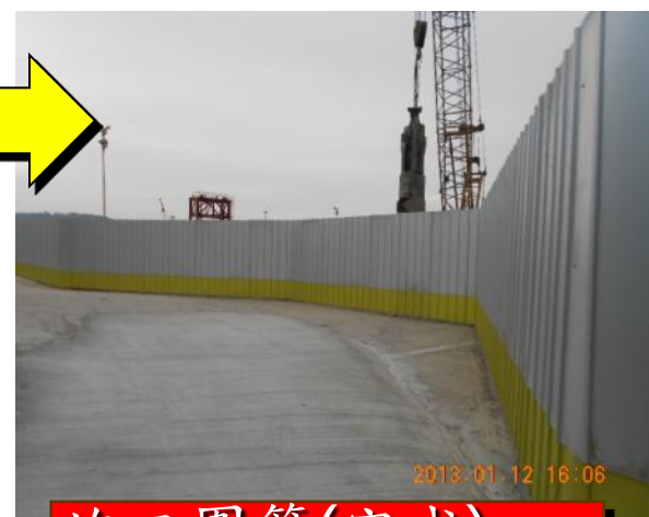
施工圍籬(完成)
