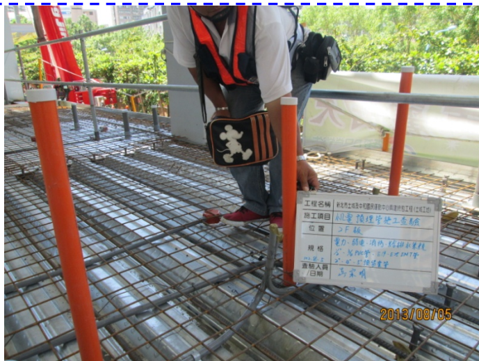
二樓版 水電配管查驗
