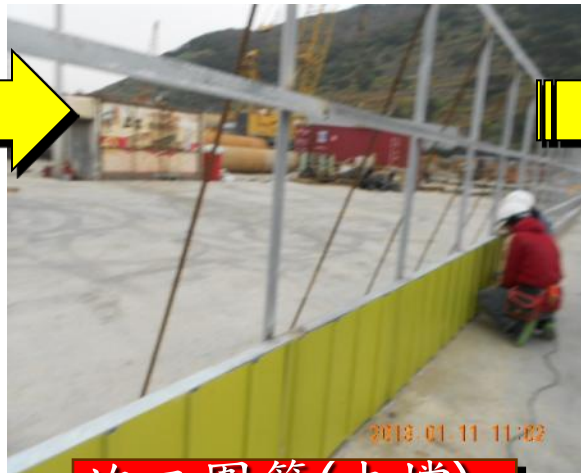
施工圍籬(支撐)
