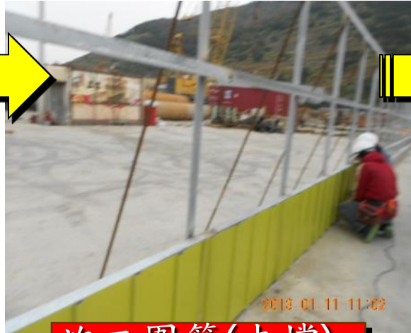
施工圍籬(支撐)
