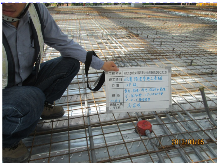
二樓版 水電配管查驗
