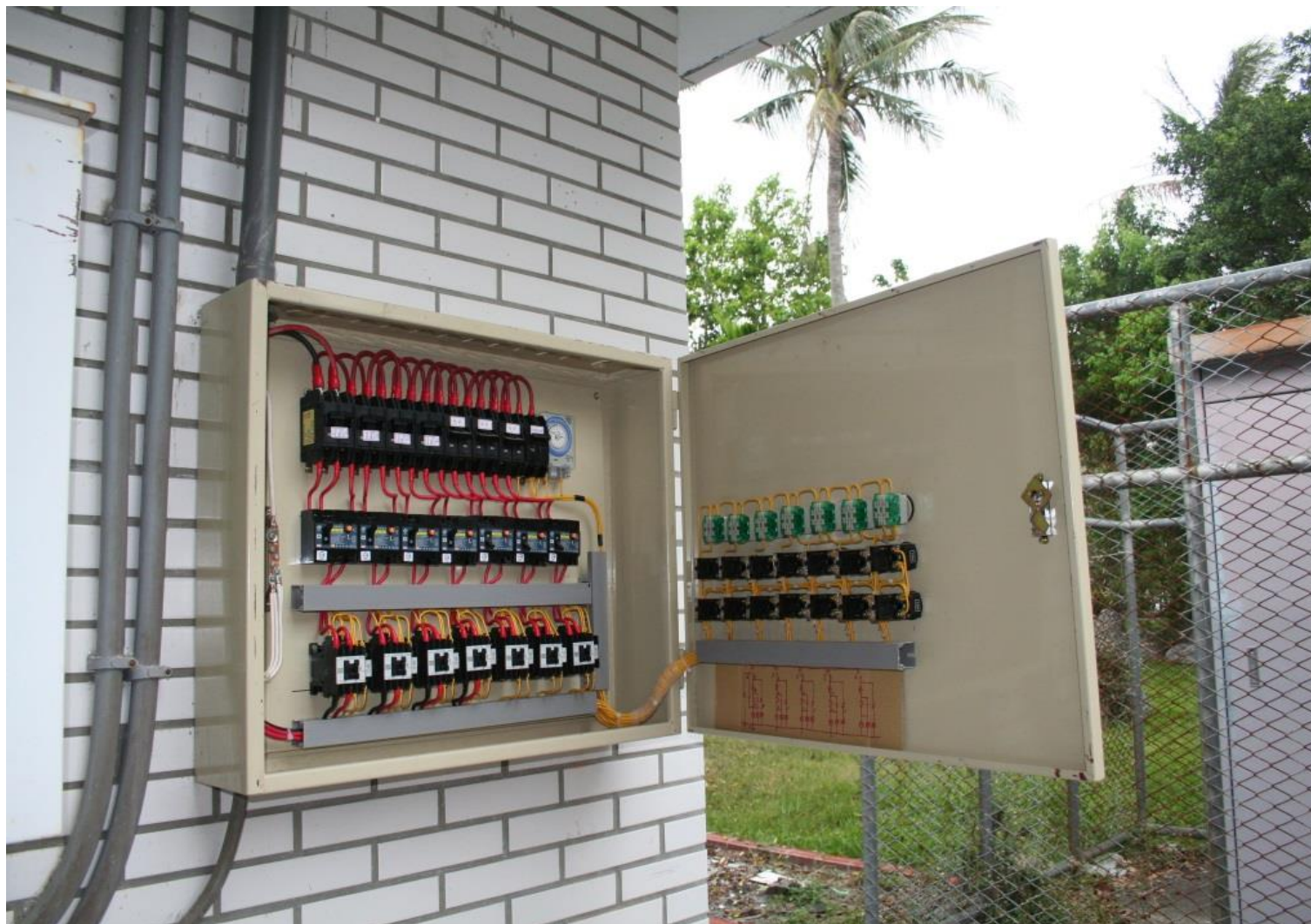
圖108工程會扣點編號5070428 說明：戶外分電箱防水等級不符規定
