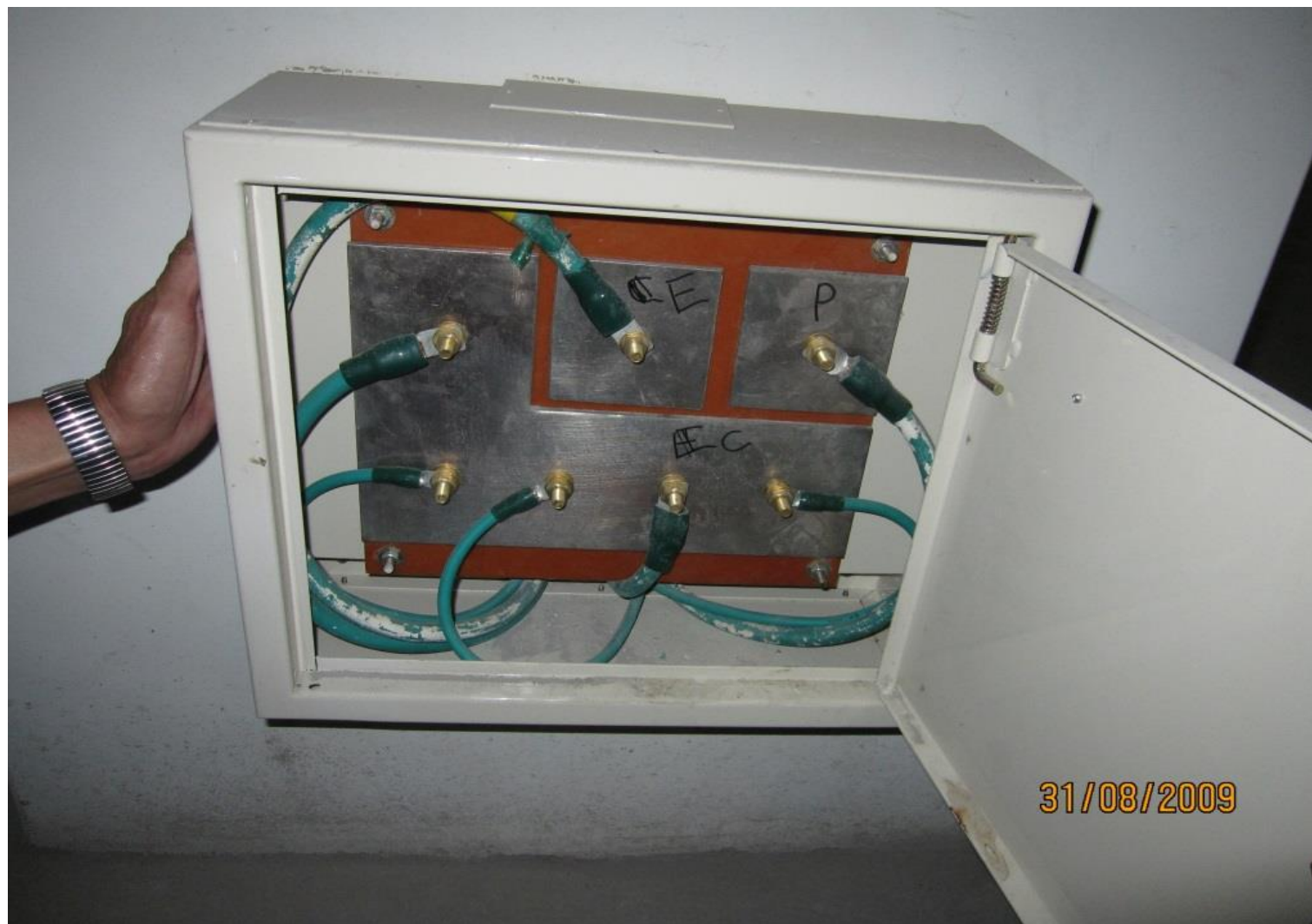
圖118工程會扣點編號5070601 說明：接地測試箱施作不合規範
