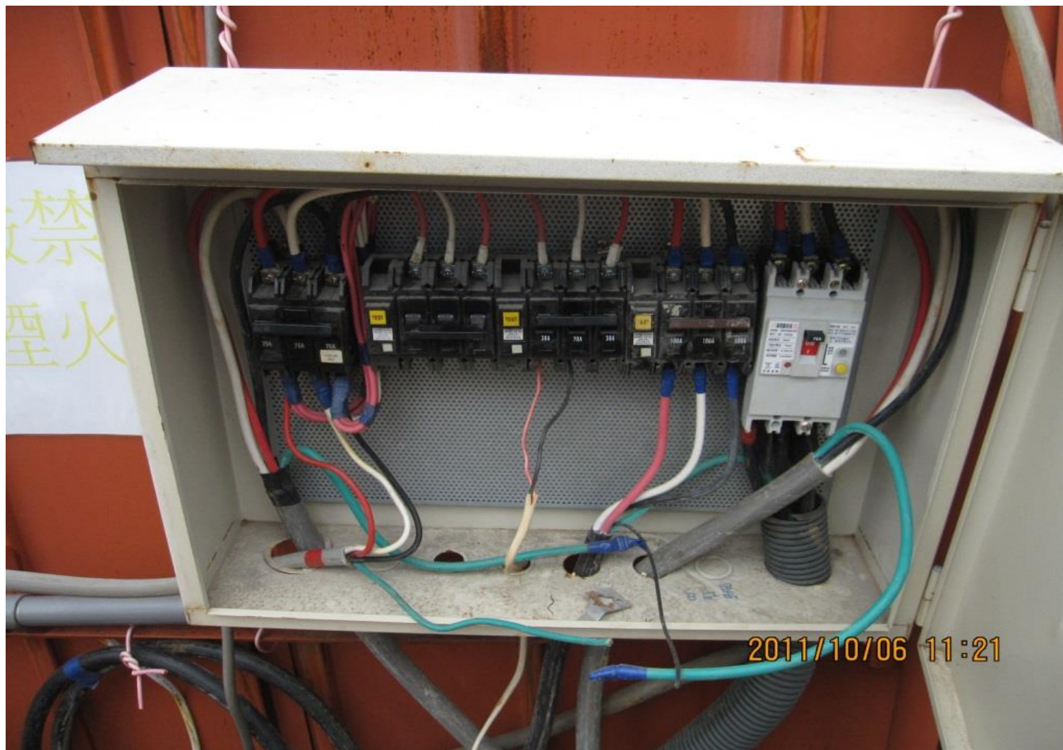
圖125工程會扣點編號5070606 說明：臨時電未接地
