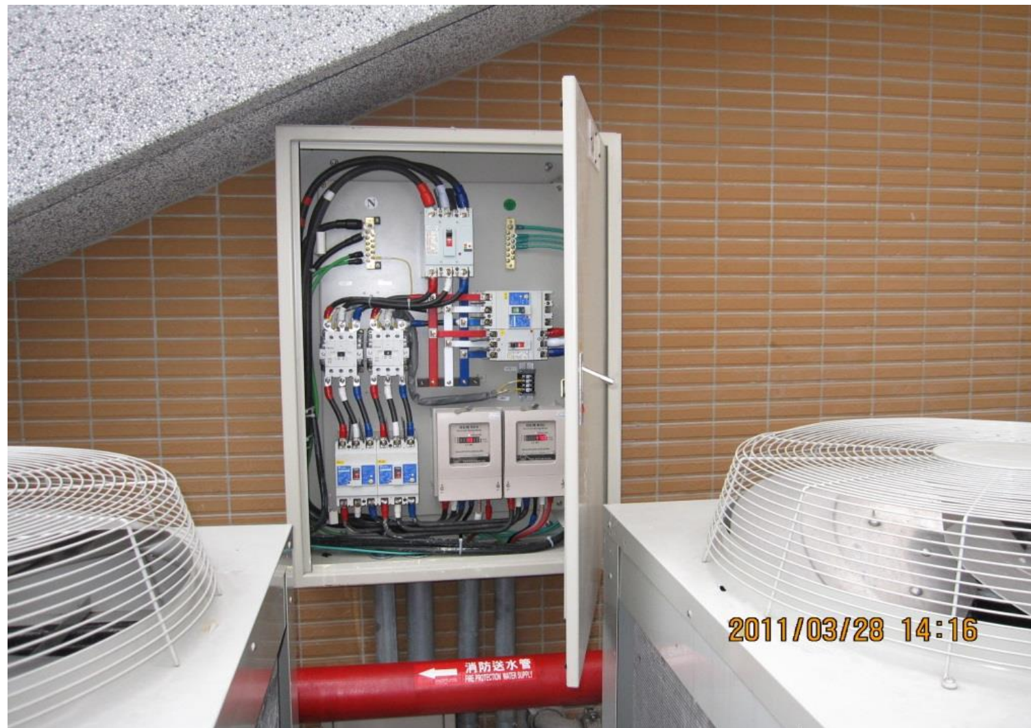
圖109工程會扣點編號5070428 說明：戶外分電箱防水等級不符規定
