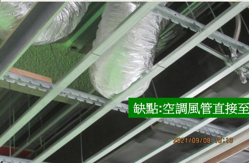
缺點：空調風管直接至於輕鋼架上，未吊裝
