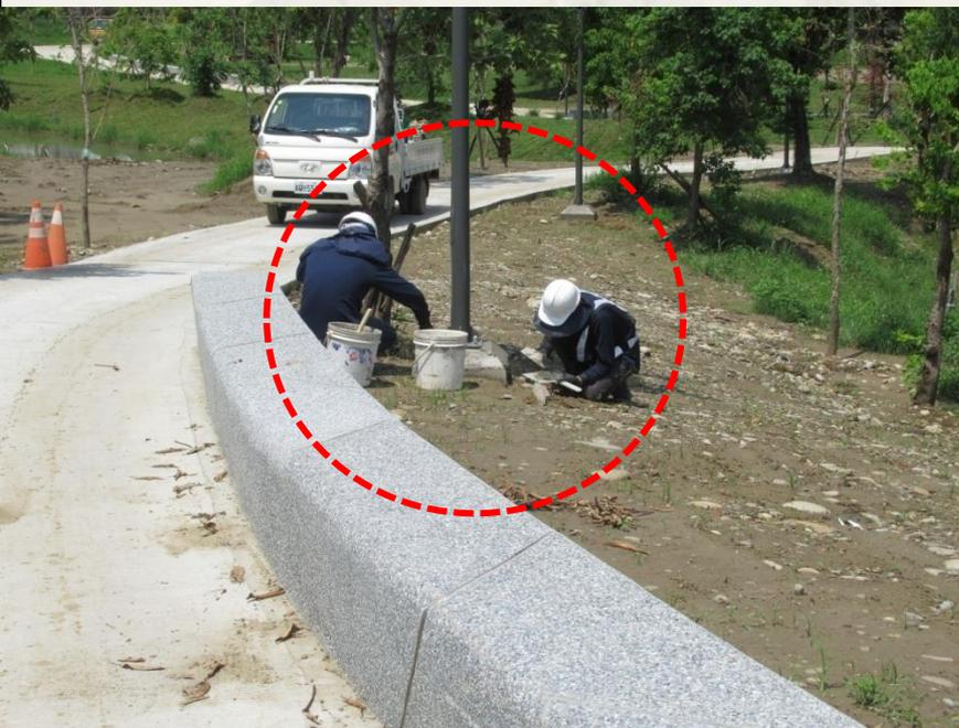
路燈或景觀燈基座，混凝土完成面應一體成形，不得二次施工以水泥砂漿粉刷
