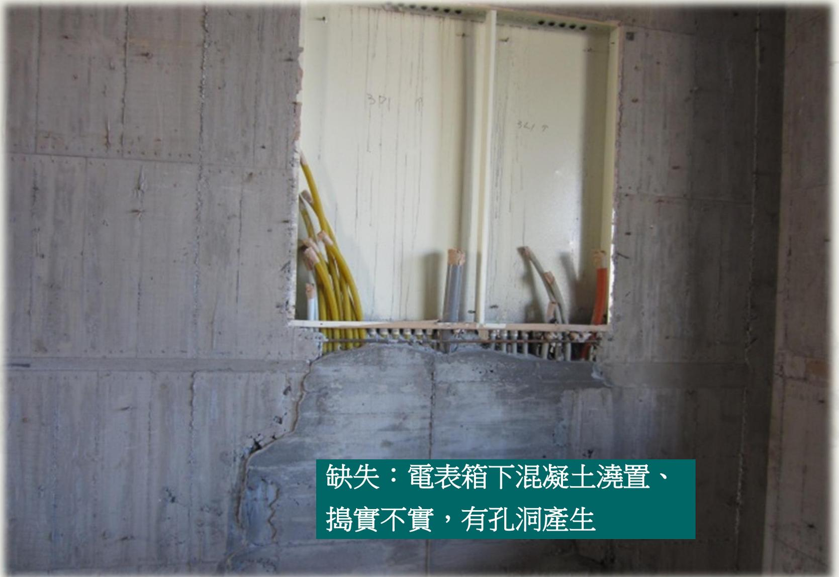
缺失：電表箱下混凝土澆置、
