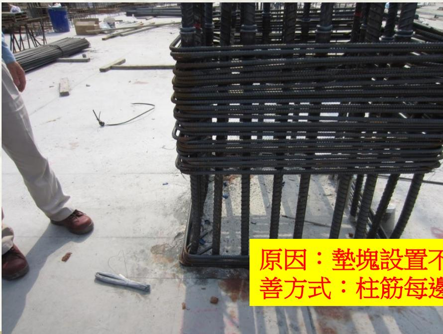
原因：墊塊設置不足或不當設置改善方式：柱筋每邊設置二塊對襯墊塊
