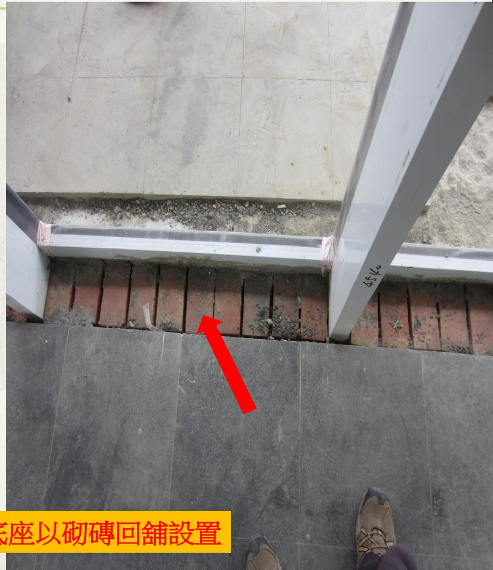
錯誤：帷幕牆底座以砌磚回鋪設置
