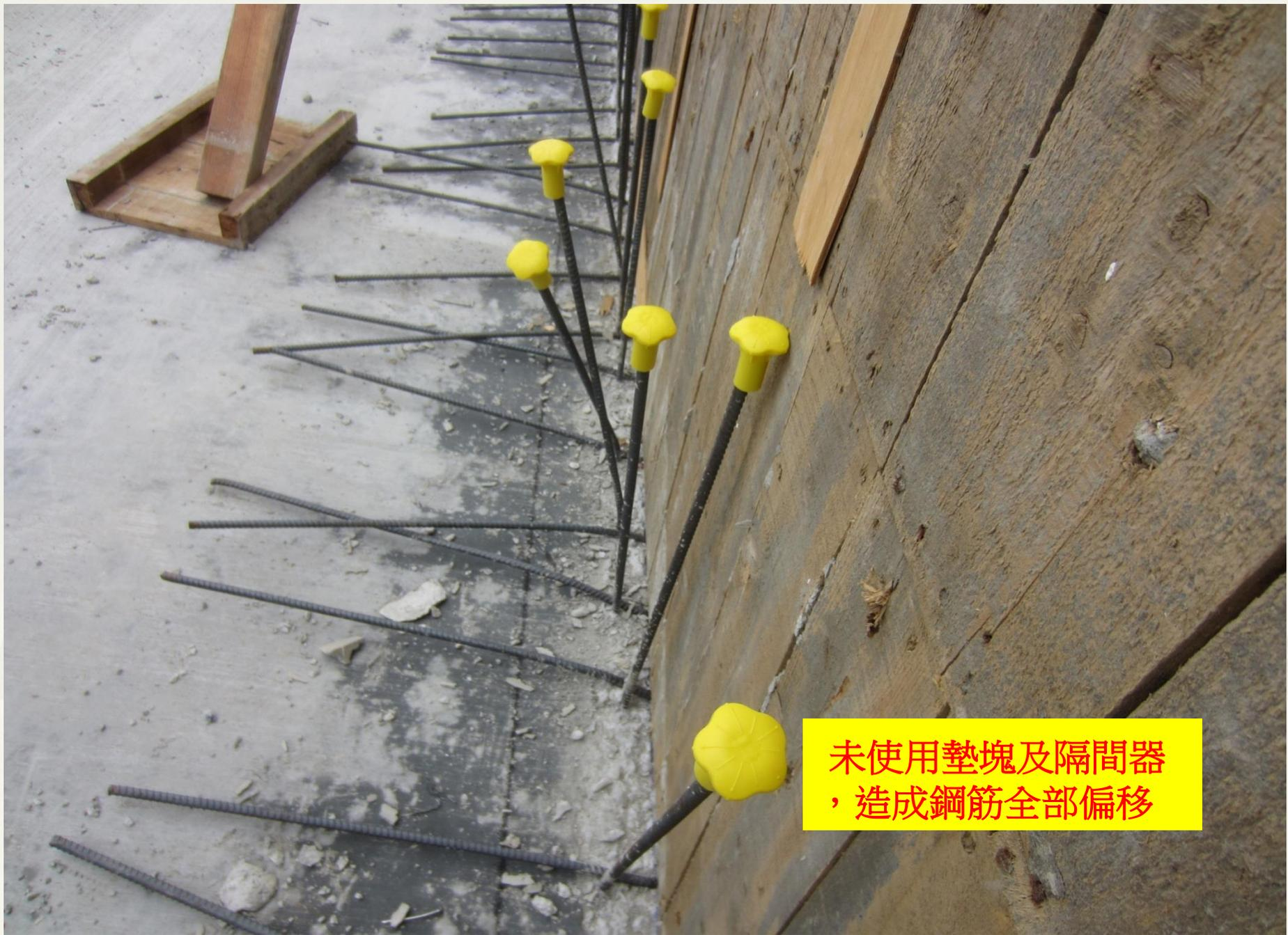
未使用墊塊及隔間器，造成鋼筋全部偏移
