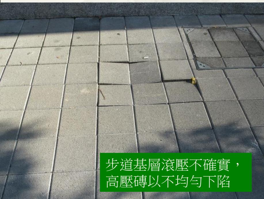
步道基層滾壓不確實，高壓磚以不均勻下陷
