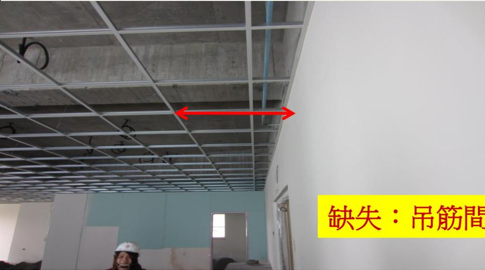
缺失：吊筋間距未符規定
