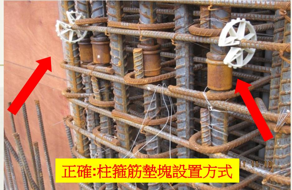
正確:柱箍筋墊塊設置方式
