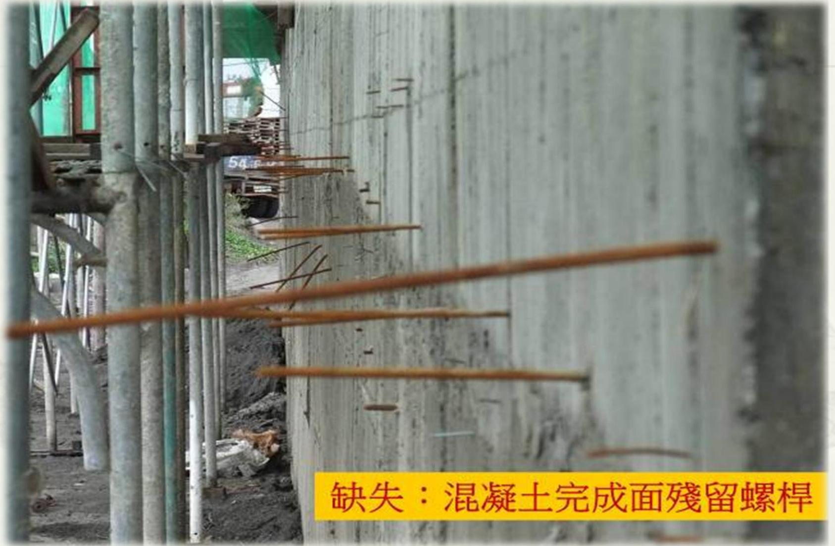
缺失：混凝土完成面殘留螺桿
