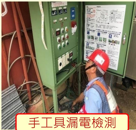
手工具漏電檢測
