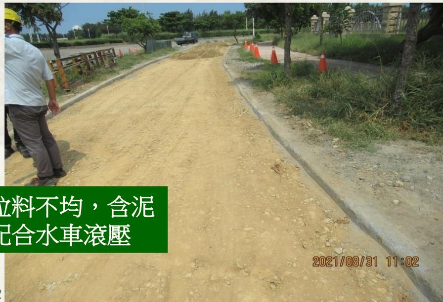
缺點：碎石級配粒料不均，含泥量太多，滾壓未配合水車滾壓
