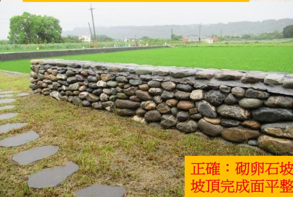
**正確：砌卵石坡面、斜率、坡頂完成面平整，整體外觀佳**
