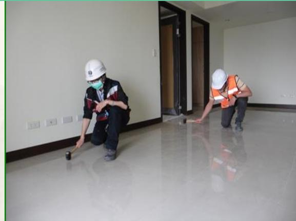
室內磁磚以橡皮槌敲擊檢驗
