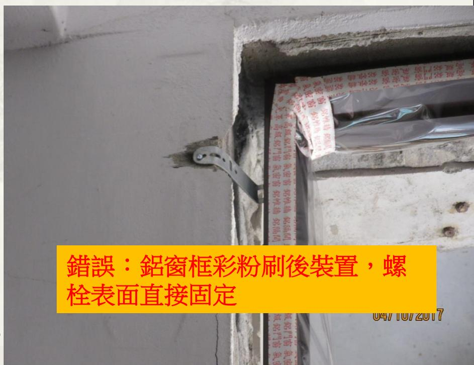
錯誤：鋁窗框彩粉刷後裝置，螺栓表面直接固定
