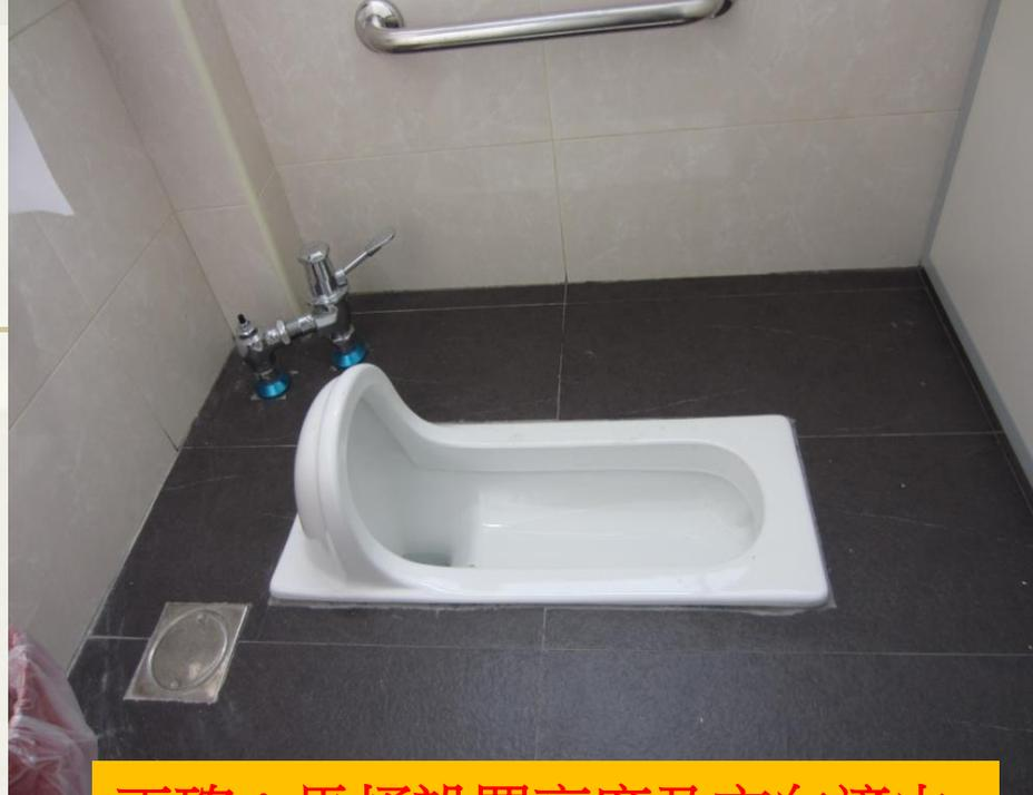
正確：馬桶設置高度及方向適中
