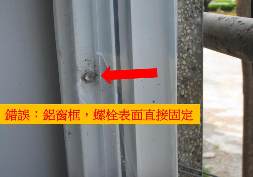
錯誤：鋁窗框，螺栓表面直接固定
