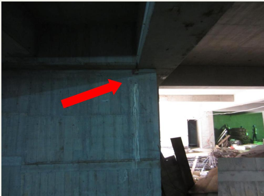
地下室外牆防水不確實，造成螺桿位置滲水
