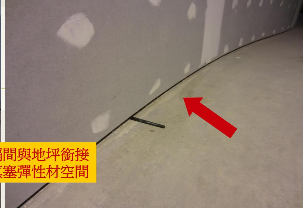
正確：輕隔間與地坪銜接，已留設填塞彈性材空間
