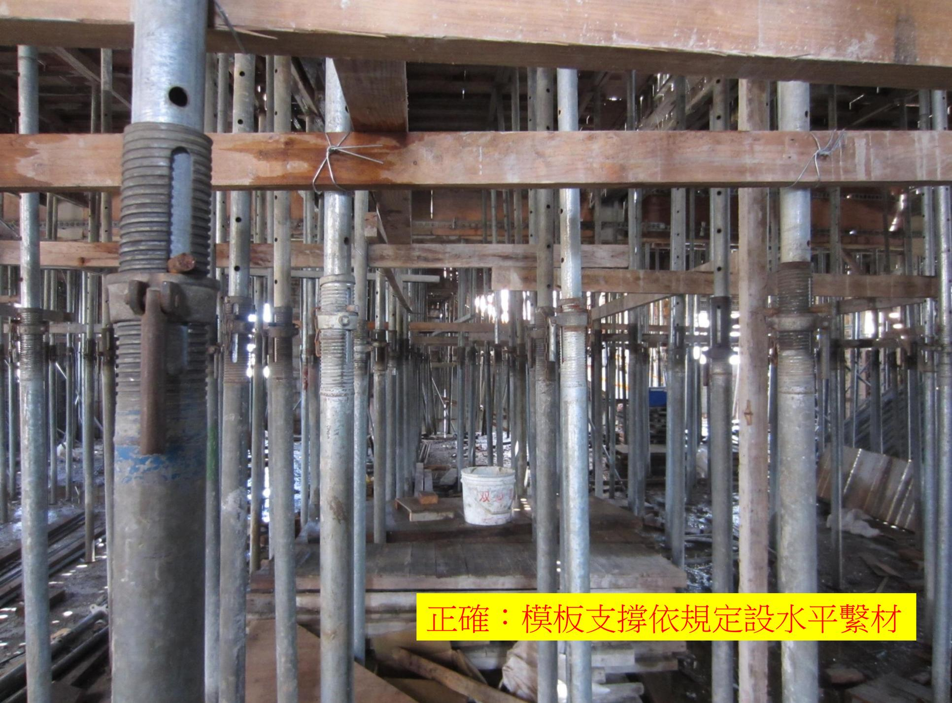
正確：模板支撐依規定設水平繫材
