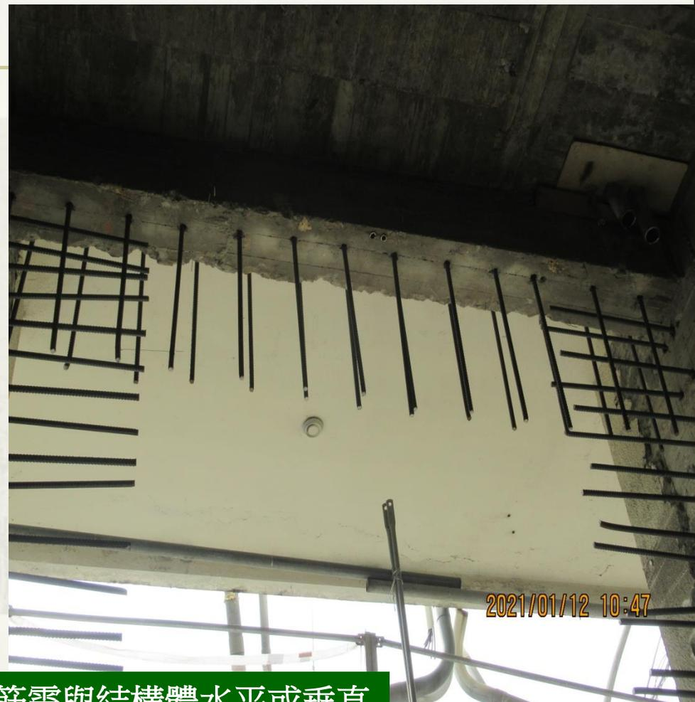
正確方式—植筋需與結構體水平或垂直
