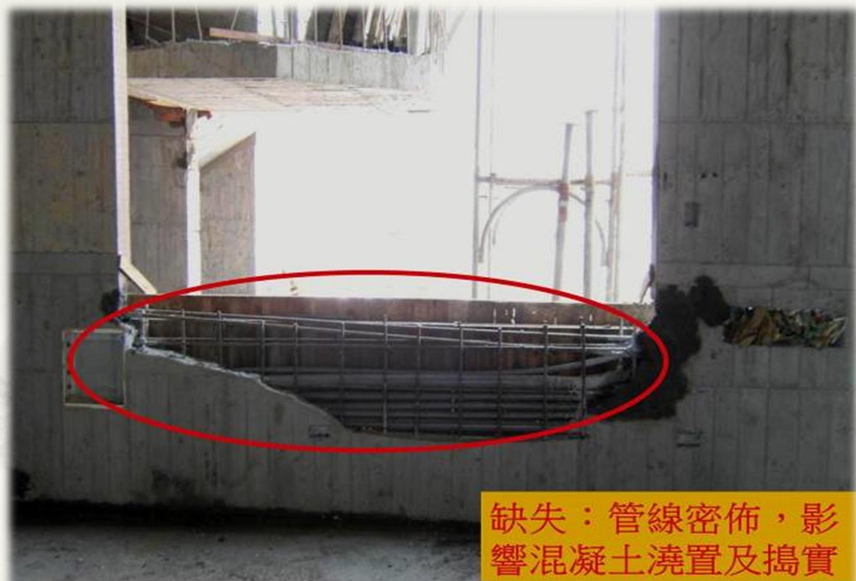
缺失：管線密佈，影響混凝土澆置及搗實
