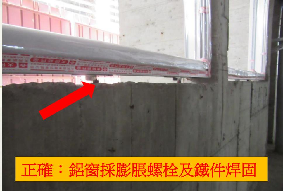
正確：鋁窗採膨脹螺栓及鐵件焊固
