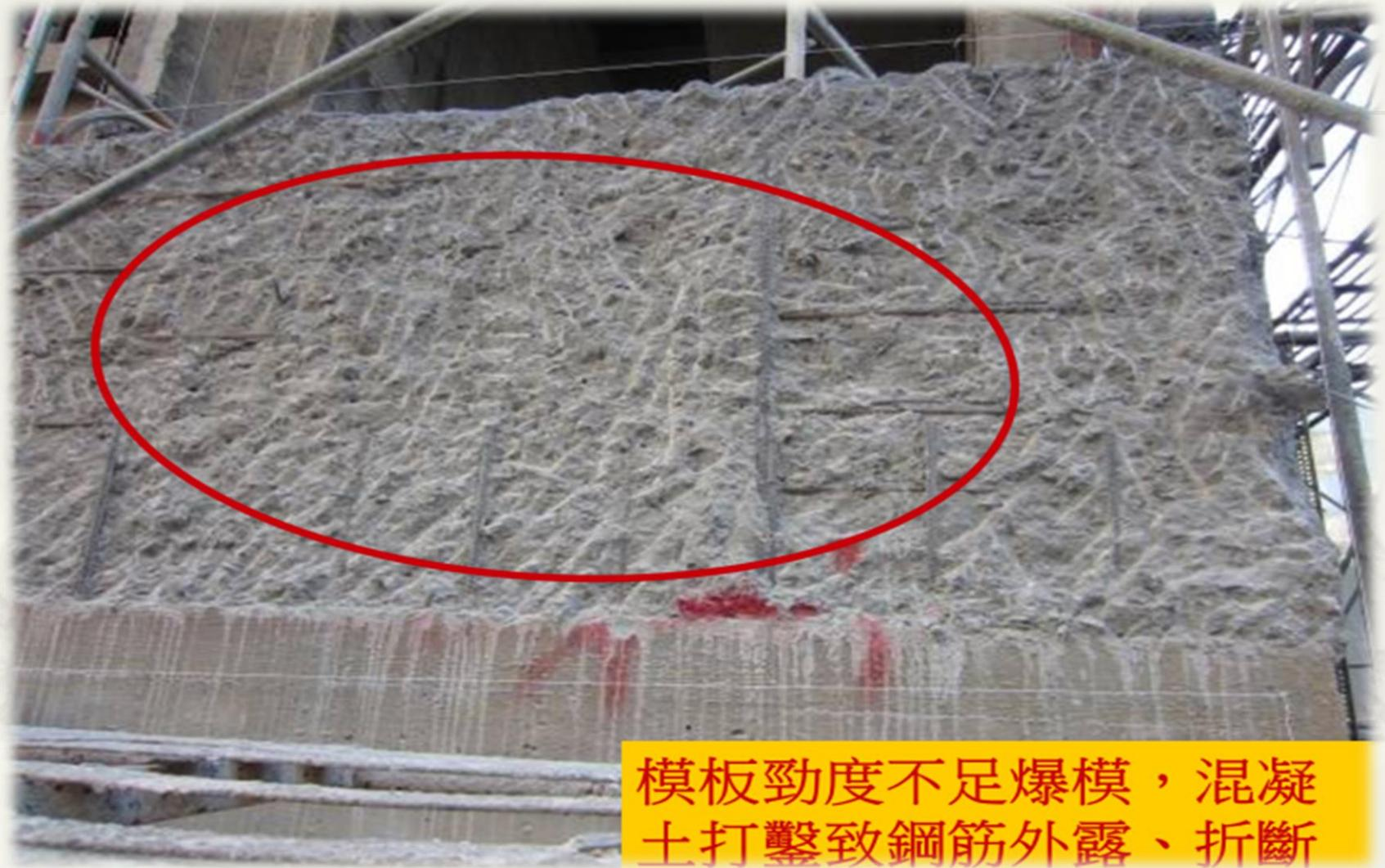
模板勁度不足爆模，混凝土打鑿致鋼筋外露、折斷
