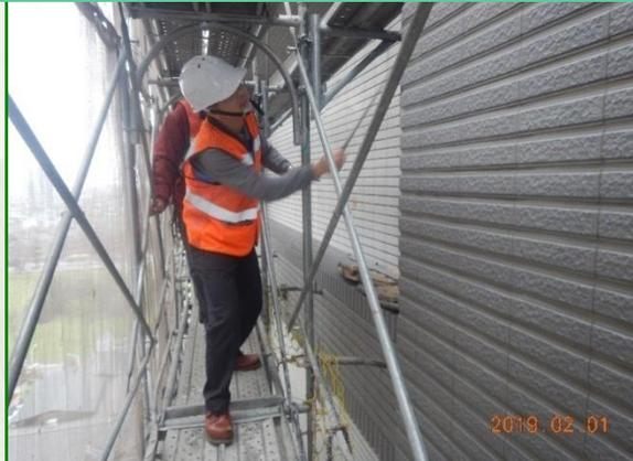
外牆磁磚進行打診棒敲擊檢驗
