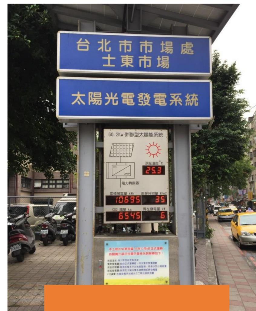
發電量顯示系統
