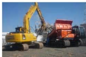
遠隔操作重機によるガレキ撤去作業 (撤去前)
