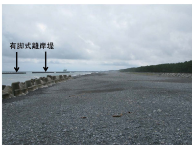
写真-10 有脚式離岸堤周辺の海浜状況（南向き）
