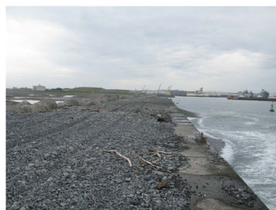
写真-5 南防波堤の天端を埋める礫
