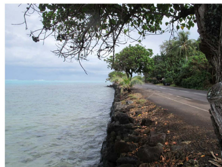
写真-4 海岸道路を守る護岸(南端の地点4)
