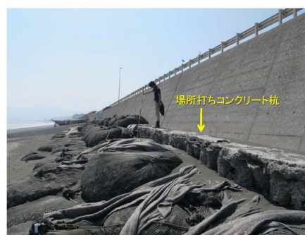
図-23 侵食されて露出した場所打ちコンクリート杭（2014年5月2日） フィルターユニットは場所打ちコンクリート杭の頭部に並べられていたが、高波浪の作用により落下した。
