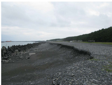
写真-8 盛り土養浜区間に残された平坦面と浜崖
