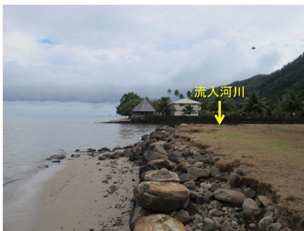
写真-1 流入河川の河口を北向きに望む(西岸の地点1) 高さ0.5m程度の石積み護岸が設置されていたが、背後の土砂の一部が流出していた。
