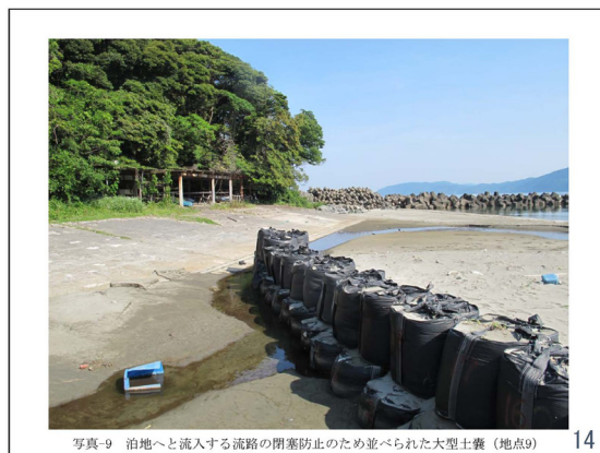
写真-9 泊地へと流入する流路の閉塞防止のため並べられた大型土嚢（地点9）
