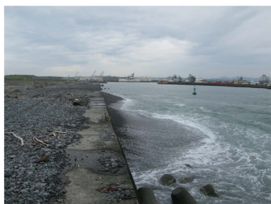
写真-6 南防波堤の内側に形成されていた砂州 ここに堆積した砂礫の一部は防波堤の天端を越えたもの、また一部は南防波堤の先端を回り込んで波により押し込まれたもの、いずれにしても南防波堤の南側の砂礫は満砂状態まで堆積が進んでいる。
