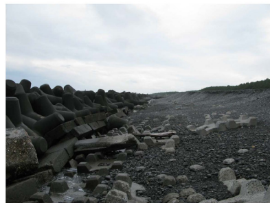
写真-9 波の侵食作用で削り取られた盛り土
