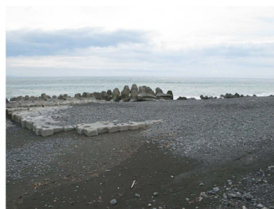
写真-15 幅広突堤上での礫の堆積状況
