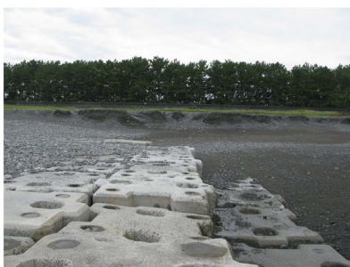
写真-14 幅広突堤の背後地にできた浜崖
