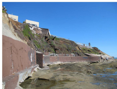
写真-8 海食台背後の護岸とその背後の崩落しつつある崖地
