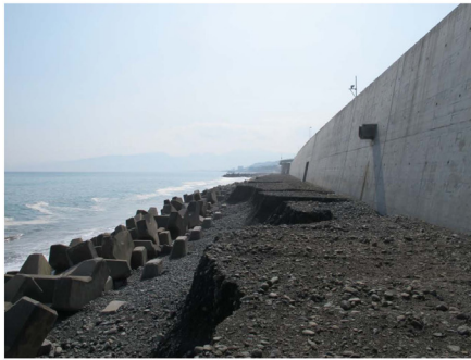
図-25 西湘バイパスの国管理区間前面での盛り土養浜（2014年5月2日） 土砂が流出し、高い浜崖が形成されている。
