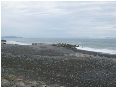
写真-12 現地試験の行われていた幅広突堤背後での堆砂状況
