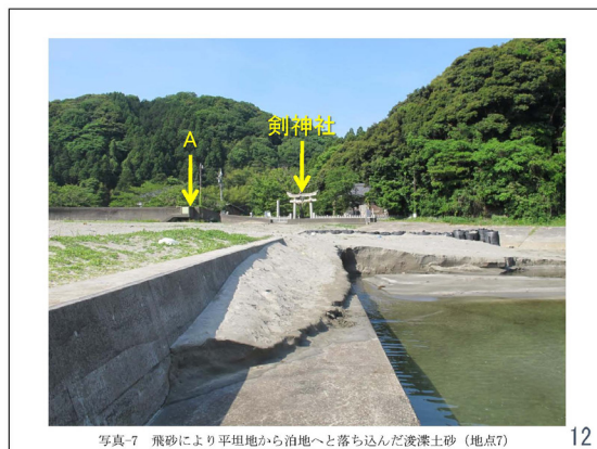
写真-7 飛砂により平坦地から泊地へと落ち込んだ浅瀬土砂（地点7）
