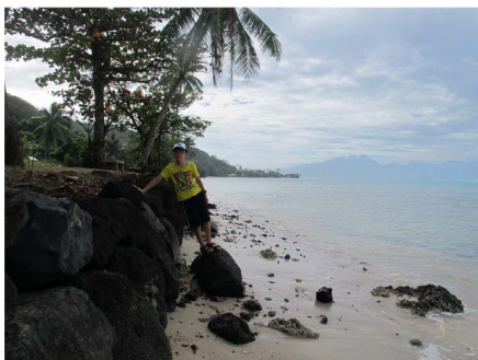
写真-5 海岸道路を守る高さ約1.5mの石積み護岸（南端の地点5）
