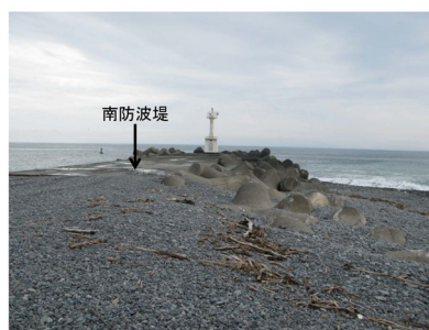
写真-3 南防波堤先端の天端を埋めた砂礫
