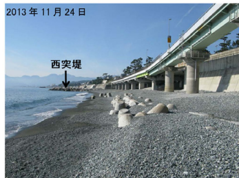
図-16 粗粒材養浜により広がった前浜と砂礫に埋まった消波工（2013年11月24日）
