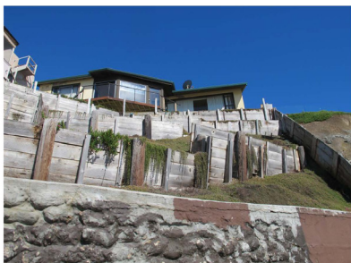
写真-7 Sea cliff上部の家屋の崩落を防止するためにproperty ownerが設置した土砂崩落防止施設 米国では崖地に住むのは個人の選択であり、公共機関が防護施設を設置する習慣はない。
