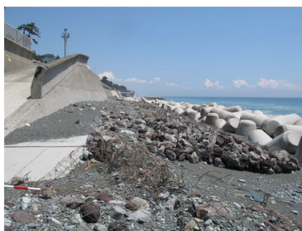
図-22 二宮海岸における破壊された鉄線電（2012年5月2日） 海岸が汚らしくかつ危険。
