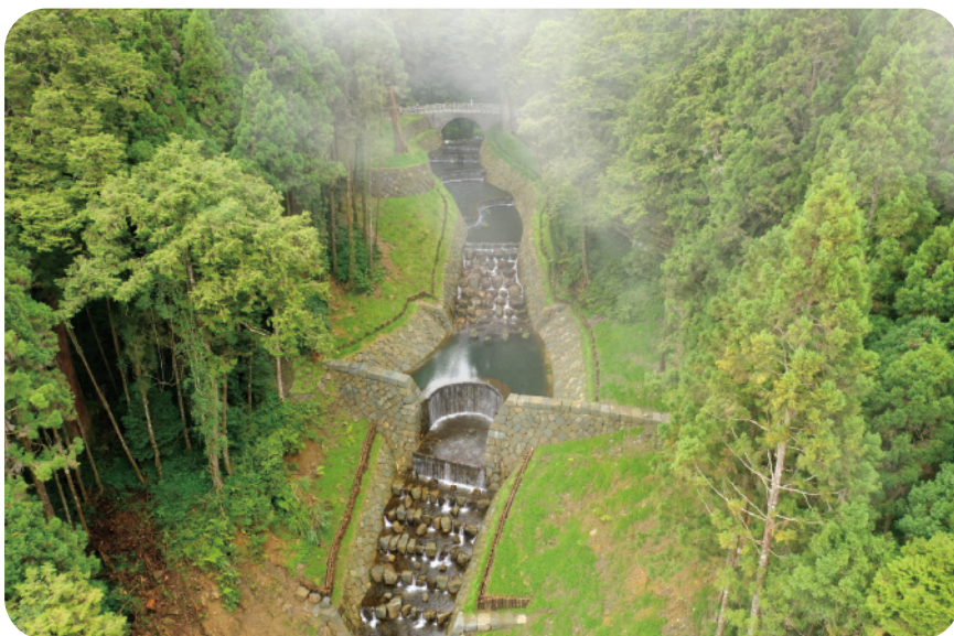
▲ 圖 23、阿里山森林遊樂區神怡橋下方野溪整治工程
