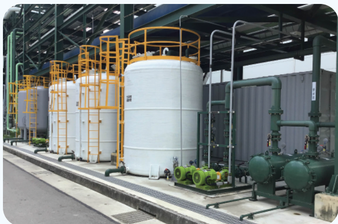
▲ 圖 25、彰濱工廠新建水回收再利用系統
