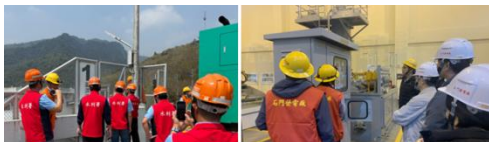
曾文溢洪道閘門啟閉演練
