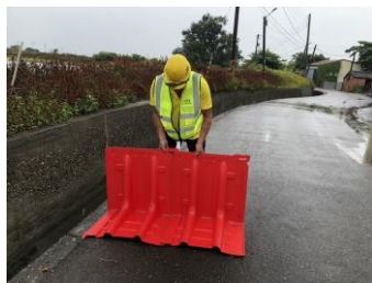
防水擋板22,664公尺
