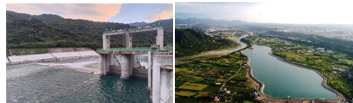
翡翠水庫原水管
