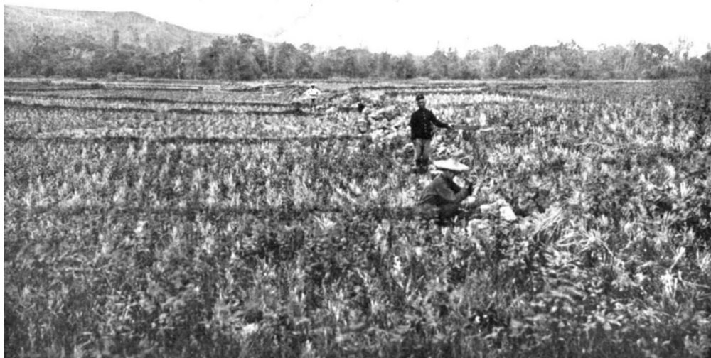
圖 1 1906 年梅山地震斷層通過嘉義縣梅山鄉三美莊(舊稱尾庄)附近的稻田； 左側（南側）地塊相對陷落 6 呎。(Omori, 1907)
