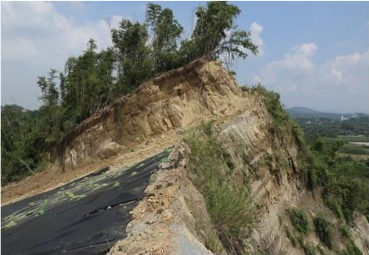
圖1 臺南市左鎮區南168-2線(原南171-1線) 2.4K 處於107年8月23日熱帶低壓事件新生順向坡的滑動崩塌。
