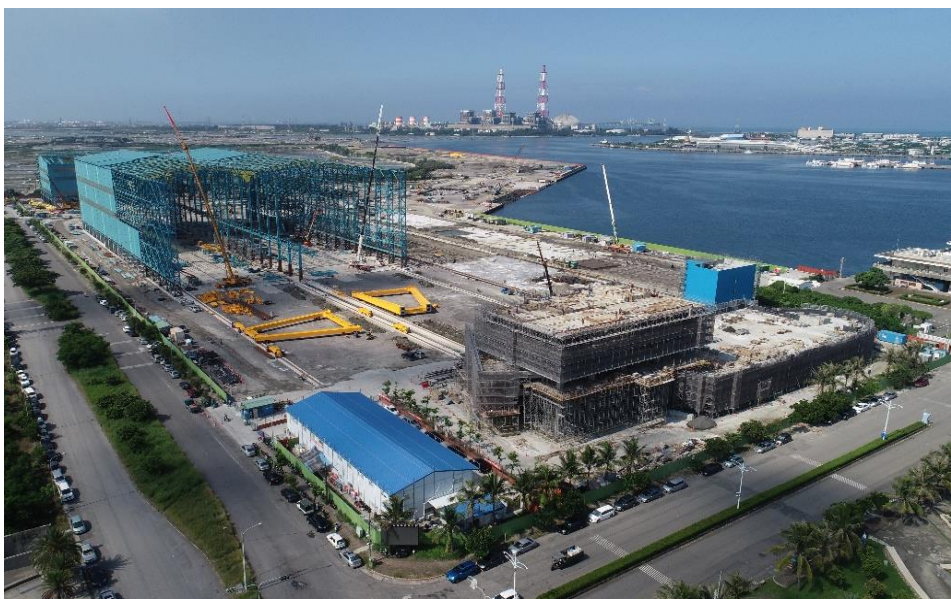
■ 興達海洋基礎公司基地空拍圖—落實發展離岸風電
