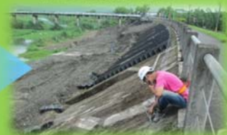
錨錠板安裝固定
