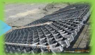
夾具固定回填土方
