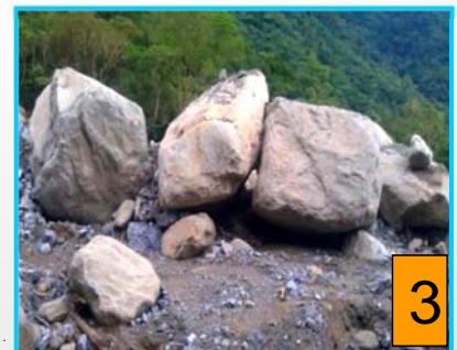
巨石阻礙河道影響通洪
