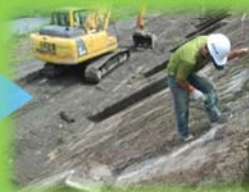
錨錠板位置鑽孔
