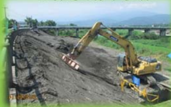
回填坡面夯平修順
