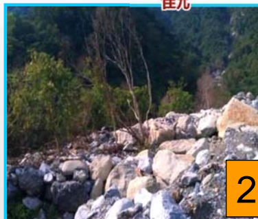
超大雨量產生超滲逕流，帶動上游土石大量下移
