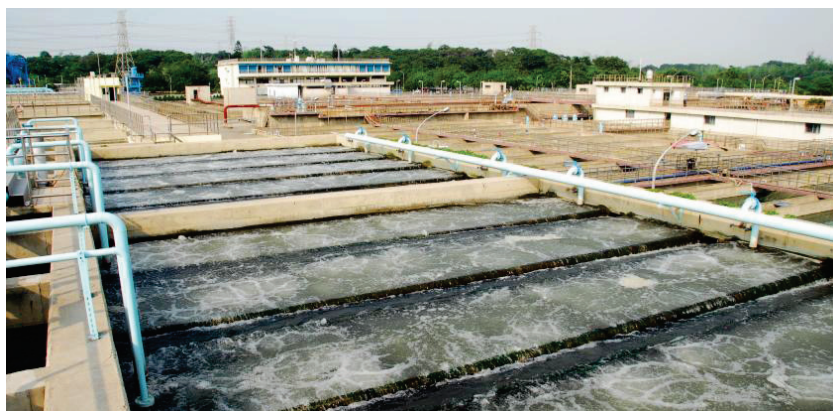
■ 台水公司-高雄鳳山給水廠
