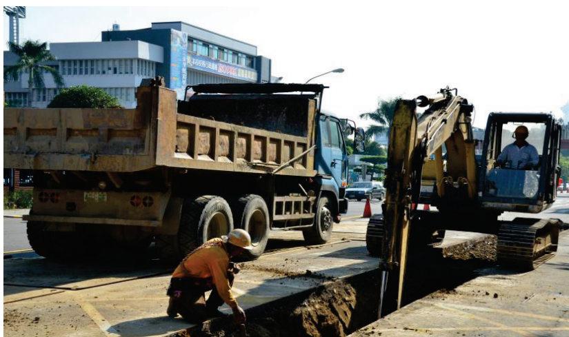
■ 台水公司-台中市區管線汰換工程
