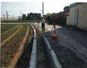
渠底清淤，並全面檢測渠底高程
