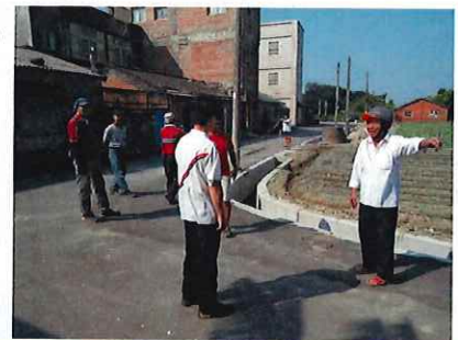
廠商表示為消除農民疑慮此段轉彎處將打除重作並依以地籍圖所示直角方式施作
