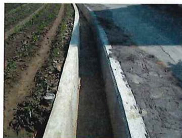
渠底清淤完成
