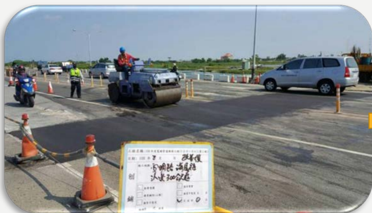
改善中：全車道刨鋪改善
