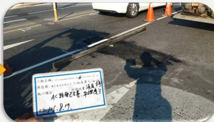
改善後：3米直規量測臨鋪平
