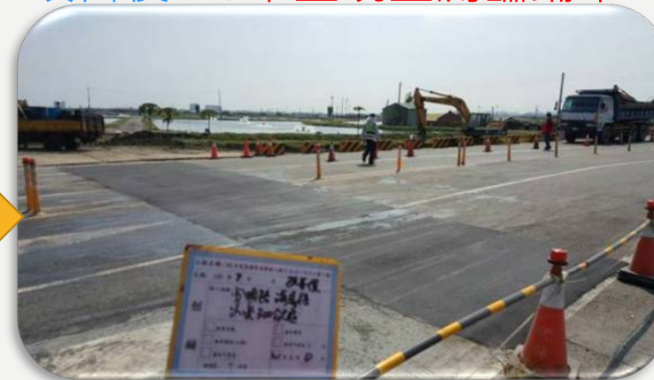
改善後：路面下陷改善完成
