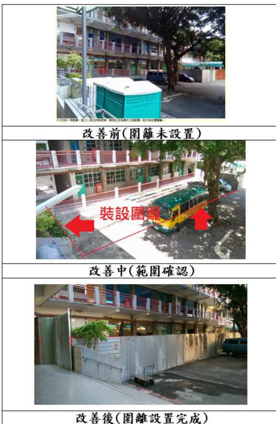
缺失改善照片
