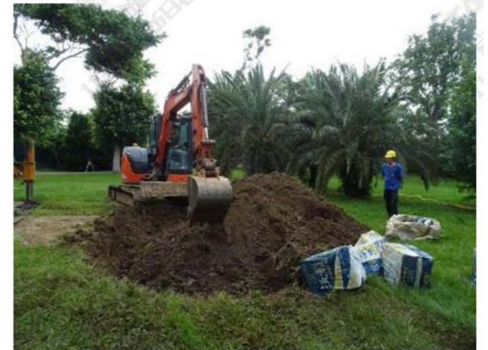
回填土混拌土壤改良材與有機質
