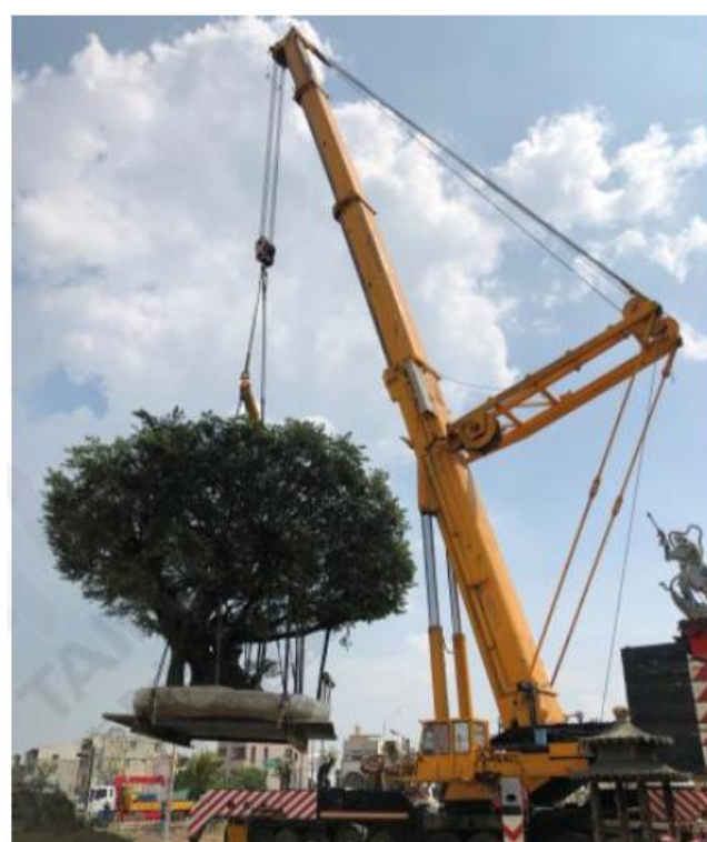
鋼構托底吊運作業示
