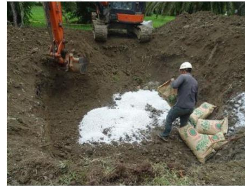
樹穴底部鋪設排水材做為底部排水層
