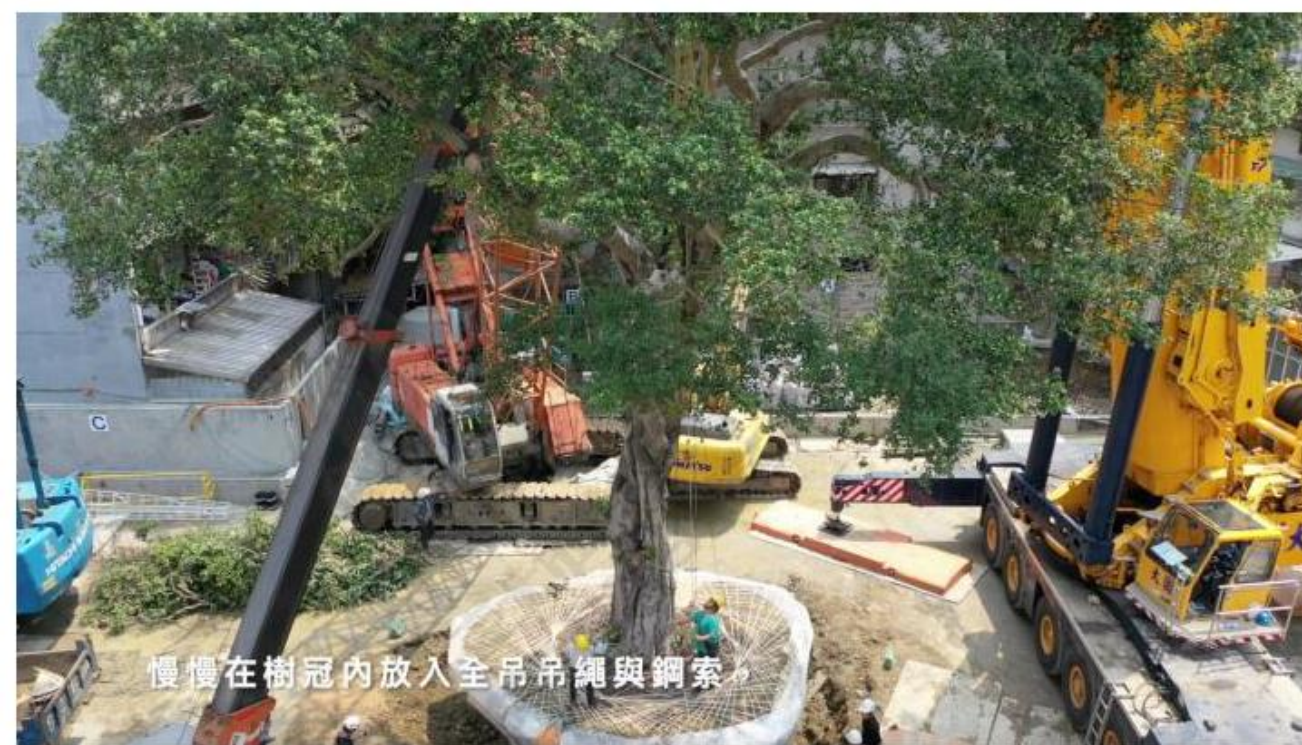
四點吊運作業示意
