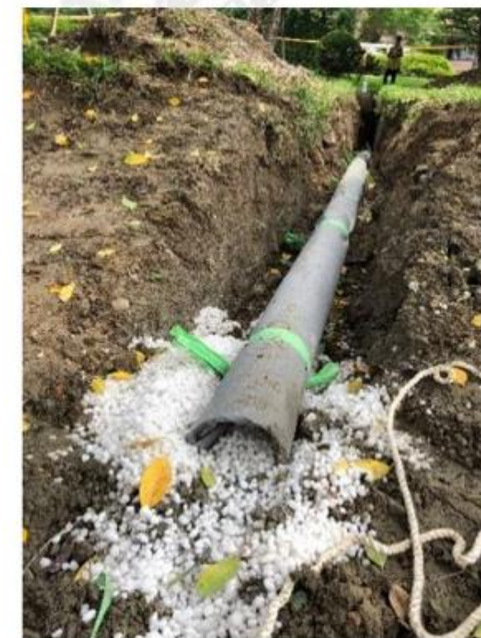
埋設 HDPE 網管連結至鄰近陰井
