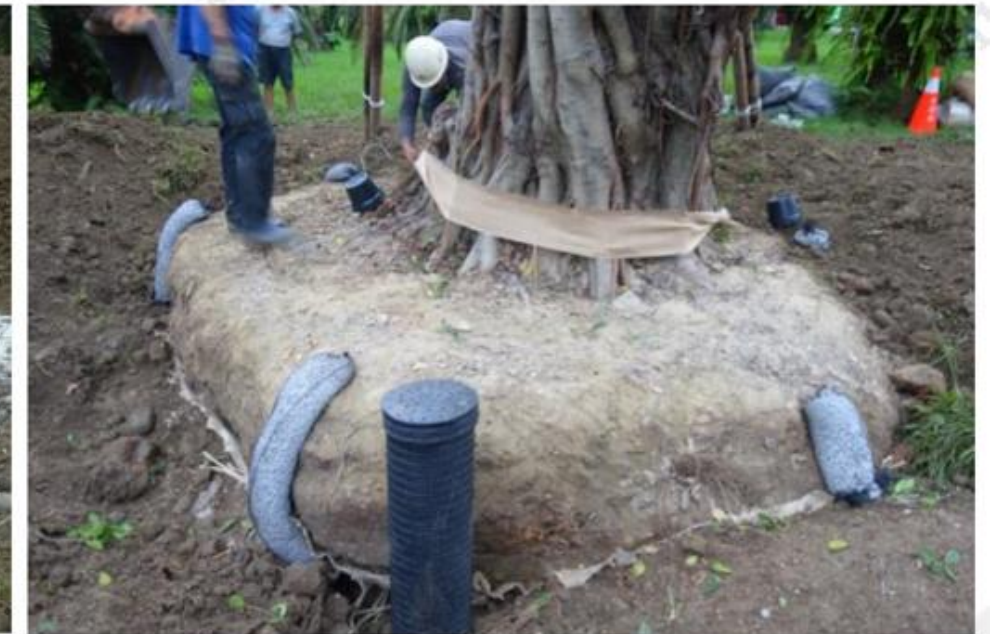
於根球四周埋設直立式通氣管與觀測井
