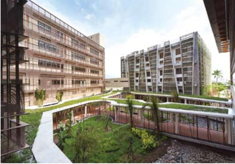
△為建置嘉創中心，工研院引進太陽能發電、水資源循環利用及環保再生建材等鑽石級智慧綠建築概念，為打造兼顧「生態」與「人性」的環境共生建築。
