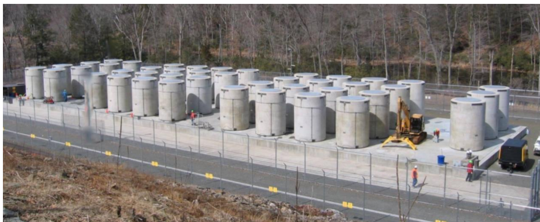
圖 3.1.1-4 美國 Yankee 電廠混凝土護箱露天貯存設施
