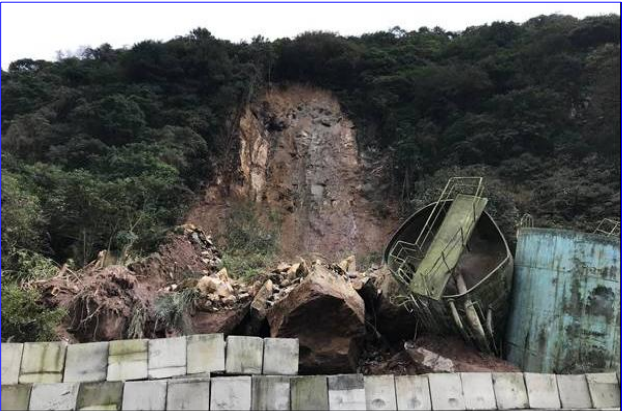
圖 1-3 原林莊淨水場損毀情況
