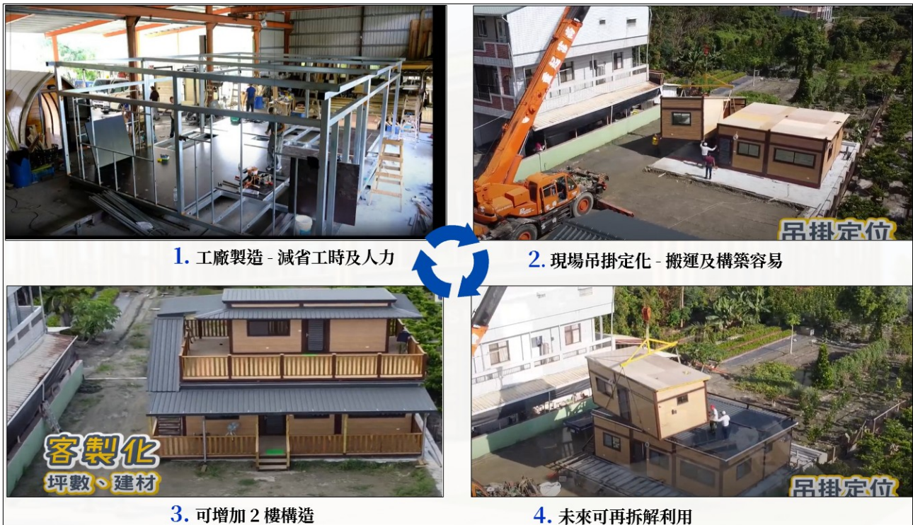
圖 2-4-1 預鑄模組化建築示意照片
