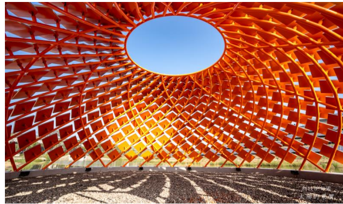
太陽果實由 386 片 50 瓦太陽能板組成，透過不鏽鋼管圓弧交疊抵禦風力
