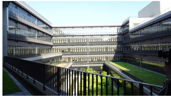
利用建築座向通風採光天井，提升綠適度，獲雙鑽級建築標章
