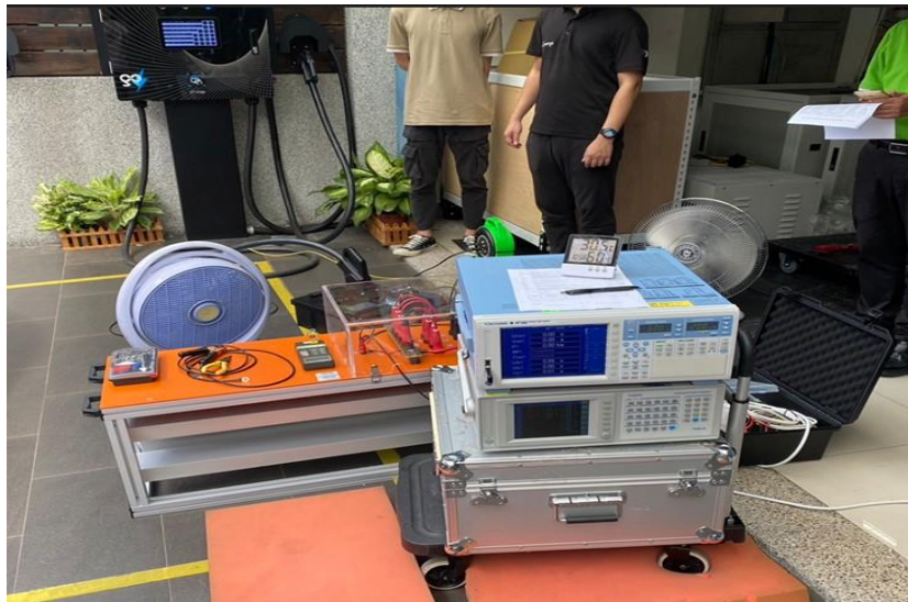
▲檢定機構進行現場電能計量檢定確保計量準確
