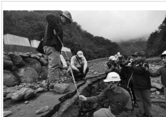
工程會人員於11月3日到南投信義鄉進行現地鑽心抽驗工程品質，發現神木國小聯外道路工程洶空毀損路段，經測量發現有混凝土厚度不足的缺失。（圖／中央社）
