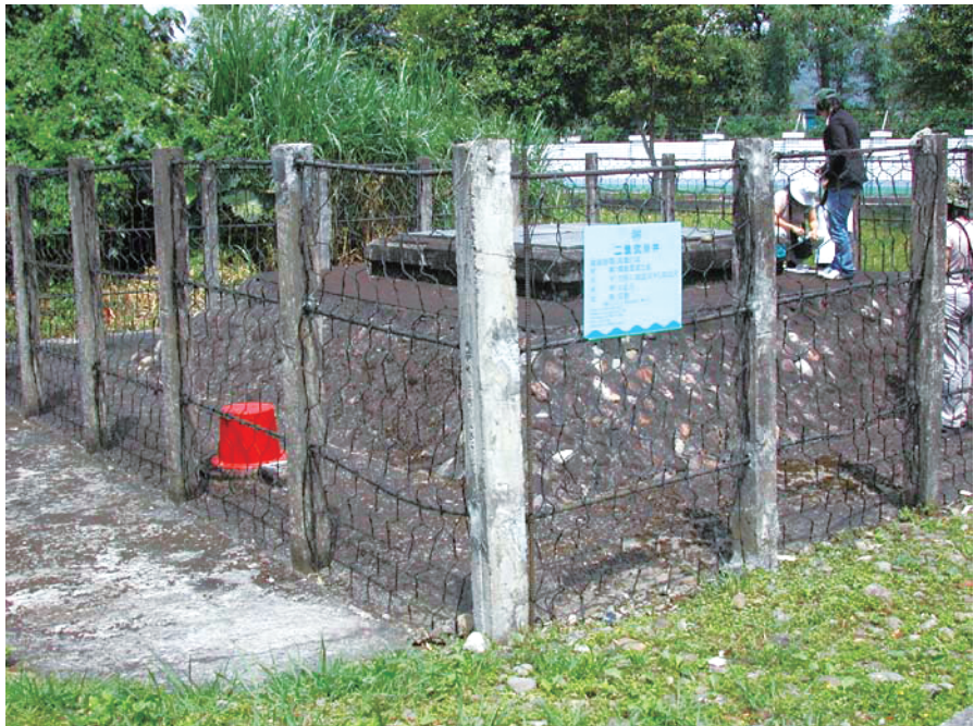
■ 台水公司-深溝淨水場 2 號沉沙井
