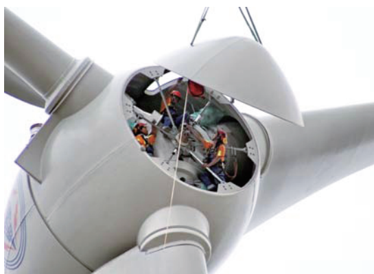
■ 台電公司-風力發電機組維修
