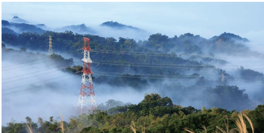
■ 台電公司-高壓輸電線路
