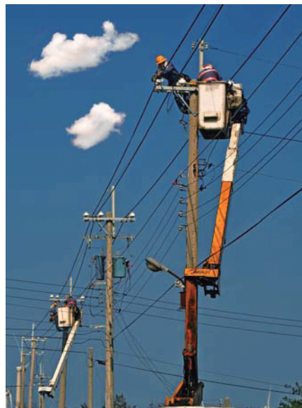
■ 台電公司-架空線路維修
