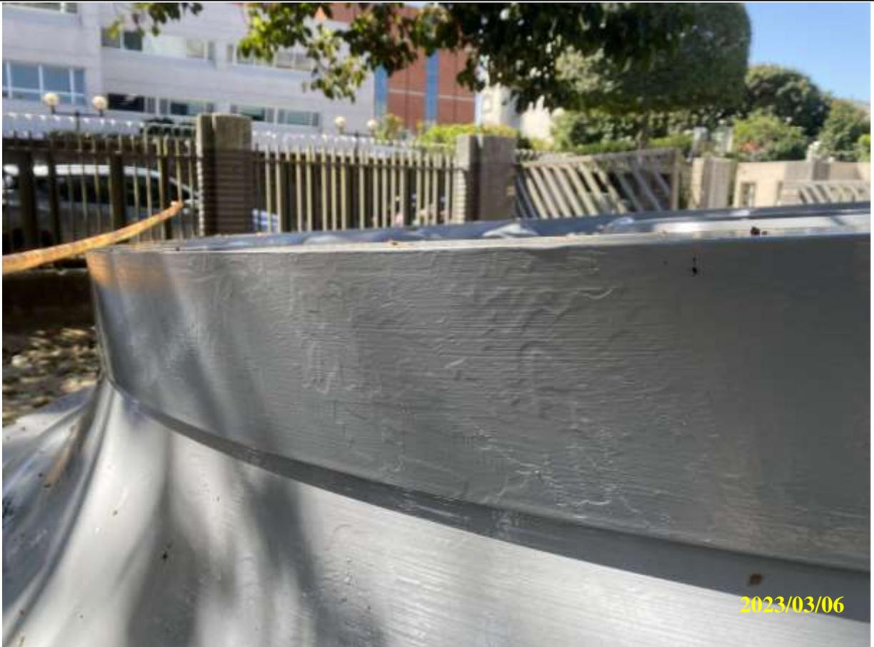
說明 水輪機殘留舊油漆未磨平即上新漆，表面凹凸欠平整。
