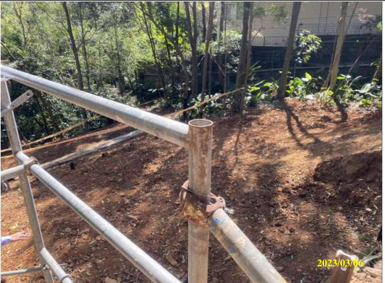
說明 施工架上下設備鋼管切口未加設管帽。
