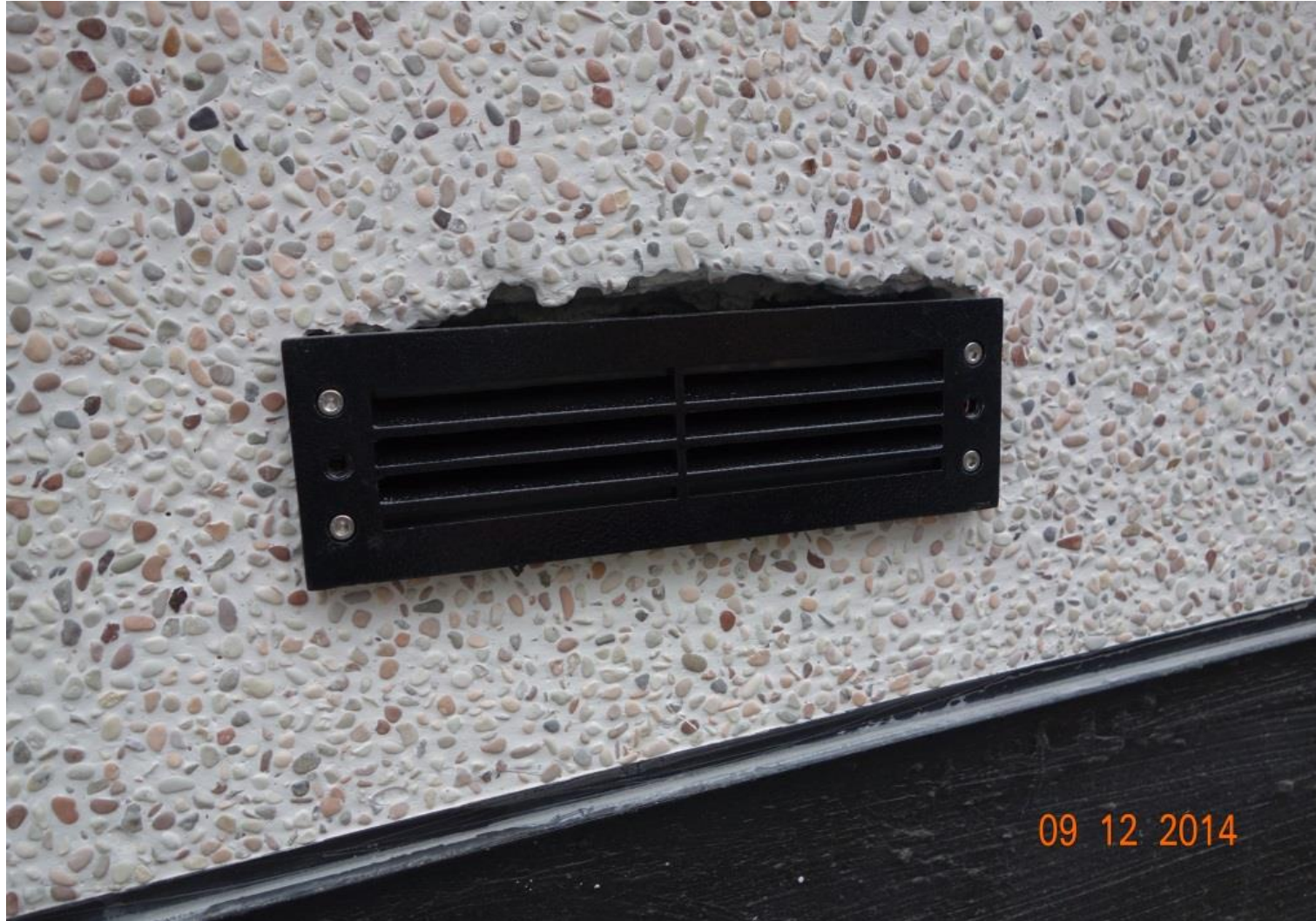
圖135工程會扣點編號5080908 說明：燈具出口修飾不良，影响美觀
