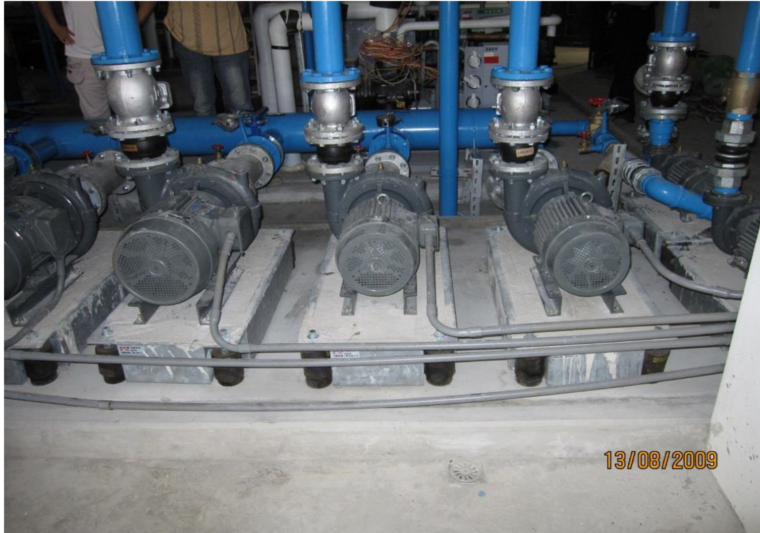
圖92工程會扣點編號5070412 說明：管路與震動設備之間未使用軟管連接
