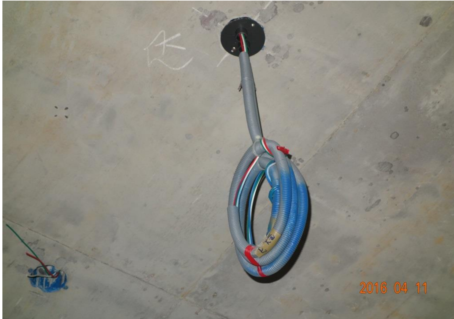
圖91工程會扣點編號5070412 說明：軟管與出線口接續不良
